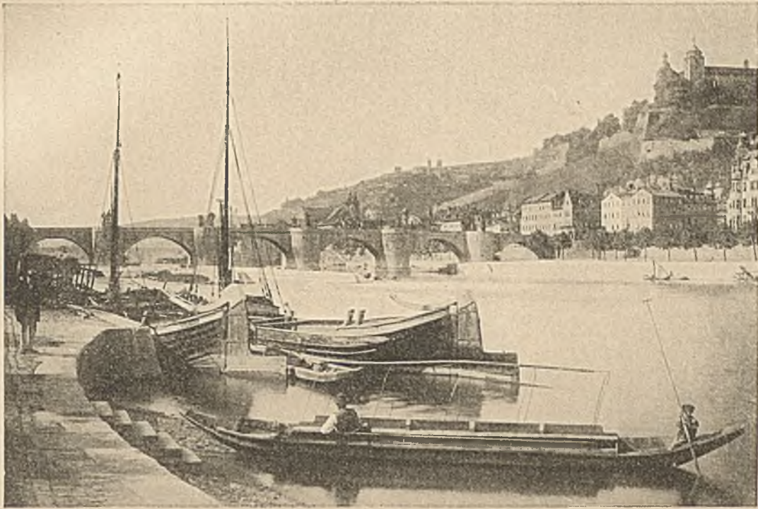
ALTE MAINBRÜCKE IN WÜRZBURG
