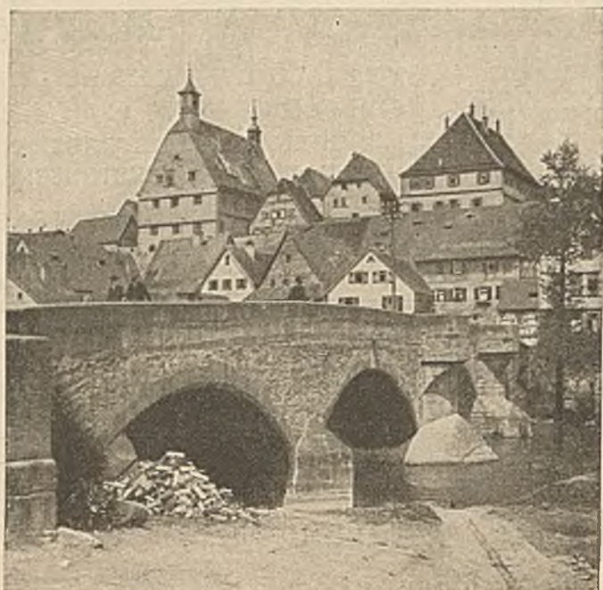
Neckarbrücke bei Besigheim (errichtet 1581)
