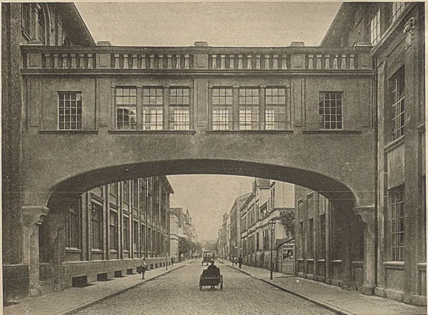
Verbindungsbrücke über eine Verkehrsstrasse in Bielefeld *
