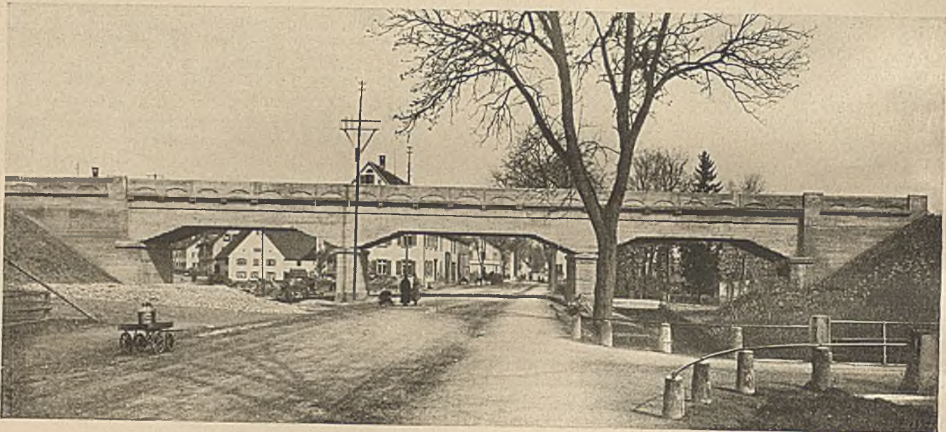
Eisenbahnbrücke über die Waldseerstrasse in Biberach
