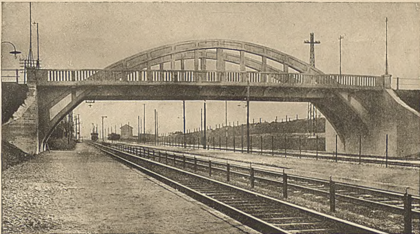
STRASSENÜBERFÜHRUNG BEI FRIEDRICHSFELD Ausgef. für die Bahnbaupinspektion III Heidelberg durch Wayss & Freytag, A.-G.
