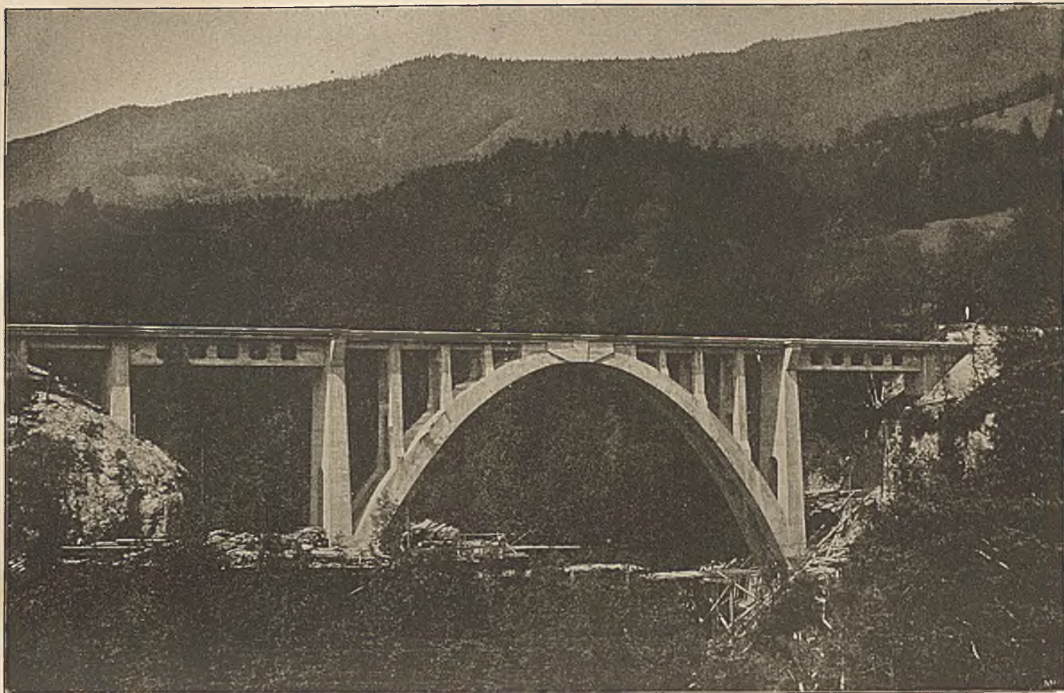
EISENBAHNBRÜCKE ÜBER DEN TIEFENGRABEN DER BAHN KLAUS-AGONITZ Ausgef. durch Wayss & Freytag, A.-G.
