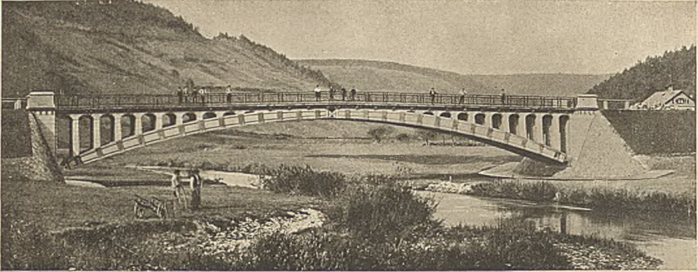
Strassenbrücke über den Neckar bei Neckarhausen
