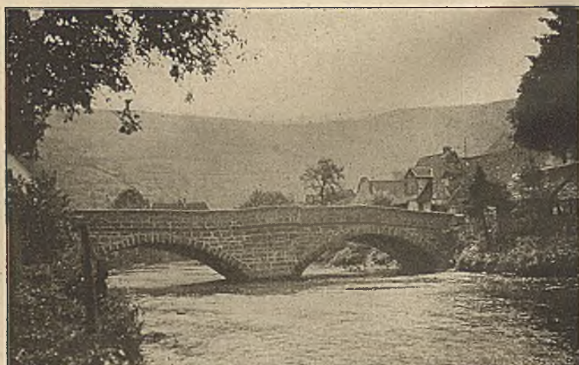
Nagoldbrücke bei Wildberg
