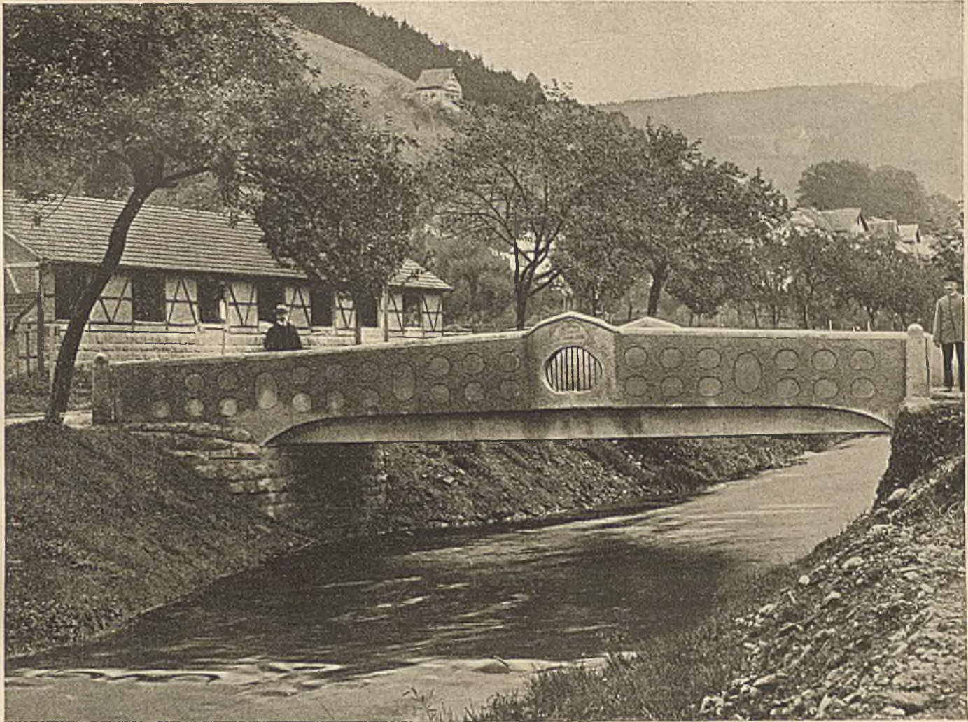
Eisenbetonbrücke in Schramberg i. Schwarzwald
