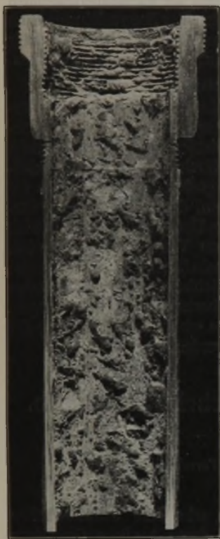
Bild 5. Emailliertes Rohr einer Warmwasserleitung nach dreijähriger Betriebszeit.
