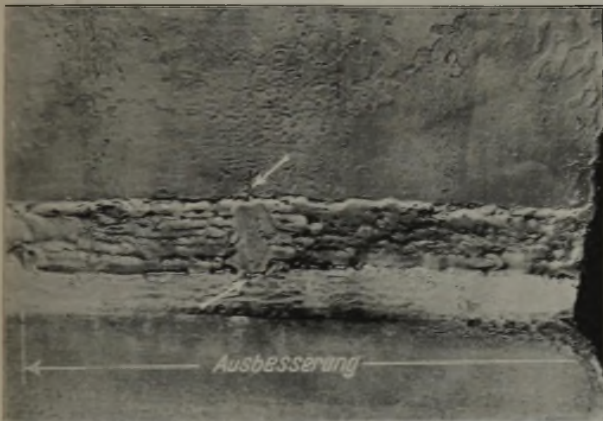
Bild 28. Ribstelle parallel zur Schweißnaht magnetisch durchflutet; Vorderseite.
