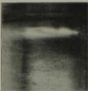
Bild 7. Durch Metallölbepulung unter Magnetfluß auf Risse geprüft.
