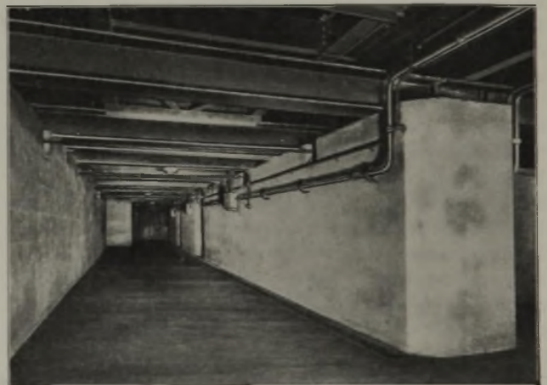
Bild 7. Mitteleisenstraße; Fundamentausbildung unter den Arbeitsrollgängen.
