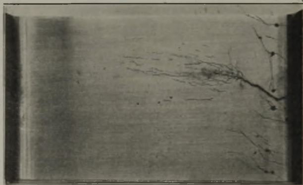
Bild 2. Risse in einem durch Ammonnitratlösung zerstörtem Träger aus unlegiertem Stahl.
