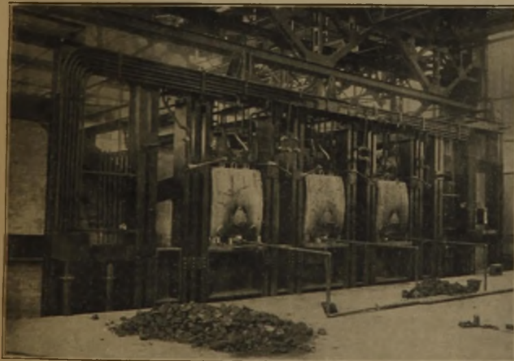
Bild 3. Oberofen des 40-t-Venturiofens von vorn.
