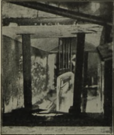
Bild 2. Inangsetzung des kontinuierlichen Tafelglasziehverfahrens nach Fourcault mit einem an Drahtseilen hängenden Fangeisen, der „Pflückleiste“. Blick in die geöffnete Ziehchamber.
