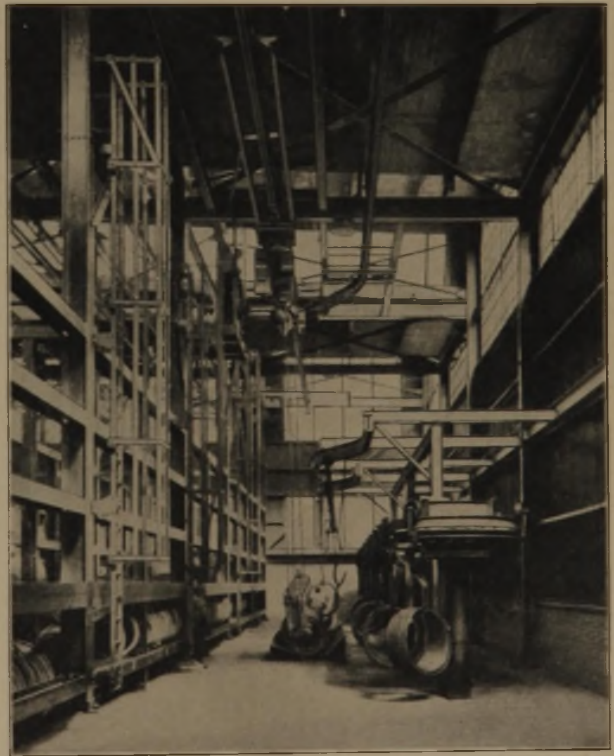
Bild 6. Luftdruckhebel-Entnahmestelle der Hängebahn.
