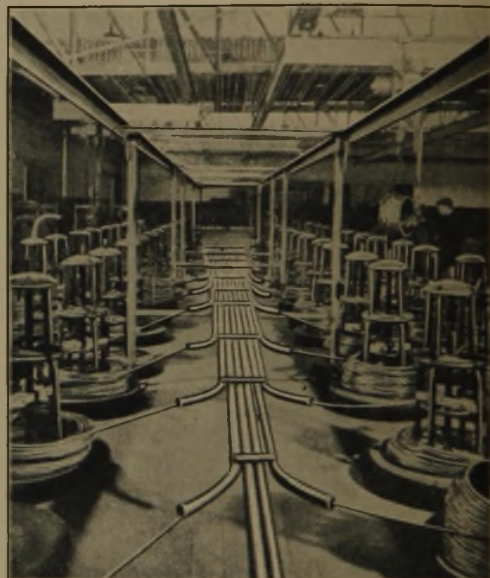
Bild 13. Ablaufvorrichtung der Drahtbunde zum Glühofen und Rückführung des geglühten Drahtes oberhalb der Ablaufkronen zum Beizbottich.
