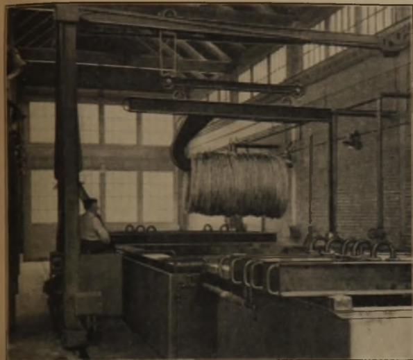
Bild 9. Beizeinrichtung für Drahtbunde.
