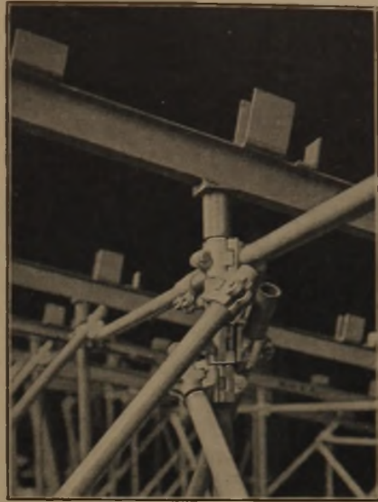
Bild 7. Lösbare Kupplung für Rohrgerüste.
