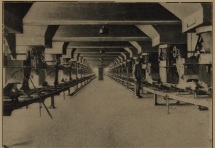
Bild 3. Teller-aus-trag mit den Förderbändern 1 und 2.
