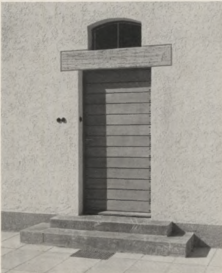
Nebengebäude beim Postamt in Kochel mit vorstehendem Pultdach. Unten: aufgedoppelte Türe mit Marmorstufen und Steinsturz
