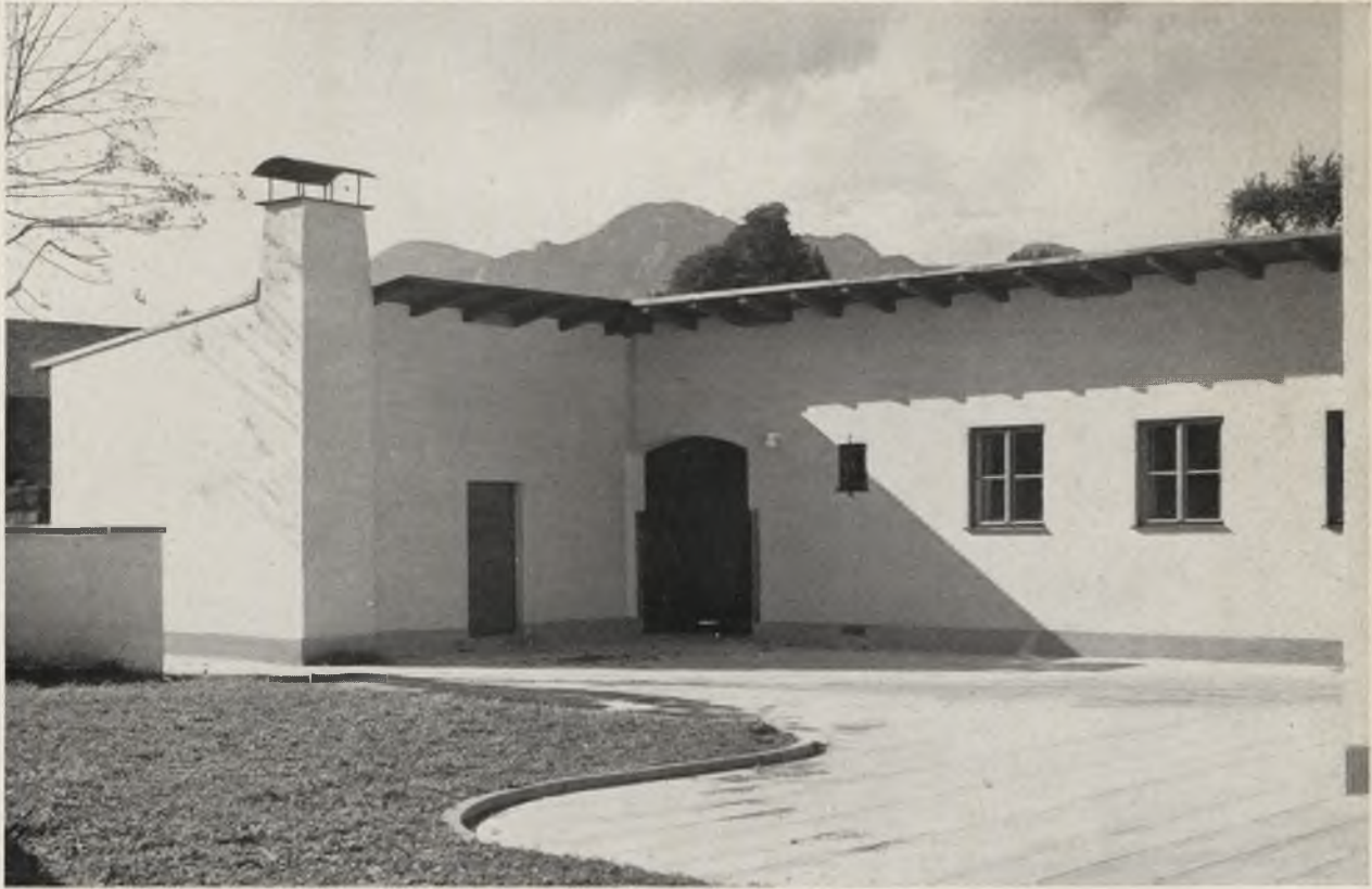
Nebengebäude beim Postamt in Kochel mit vorstehendem Pultdach. Unten: aufgedoppelte Türe mit Marmorstufen und Steinsturz
