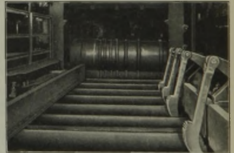
Abbildung 4. Kanter mit besonders ausgebildeten Kantklauen und gerilltem Verschiebelineal.
