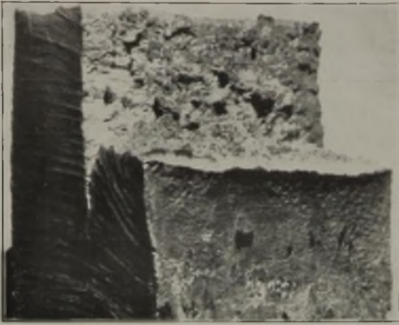
Abbildung 7. Kesselblech E, Treppenbruch infolge Dopplung.
