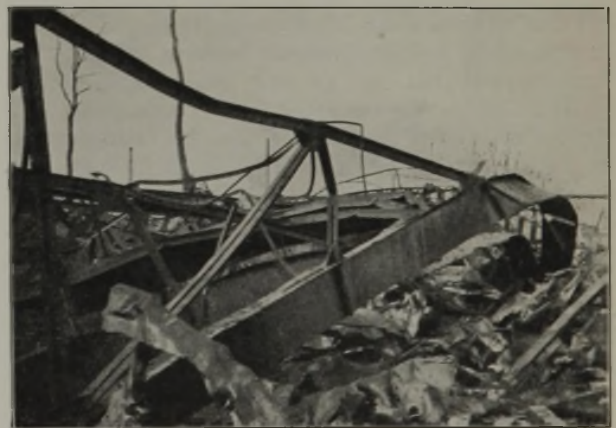
Abbildung 14. Aufwölbung der Träger im Nordwest-Viertel.
