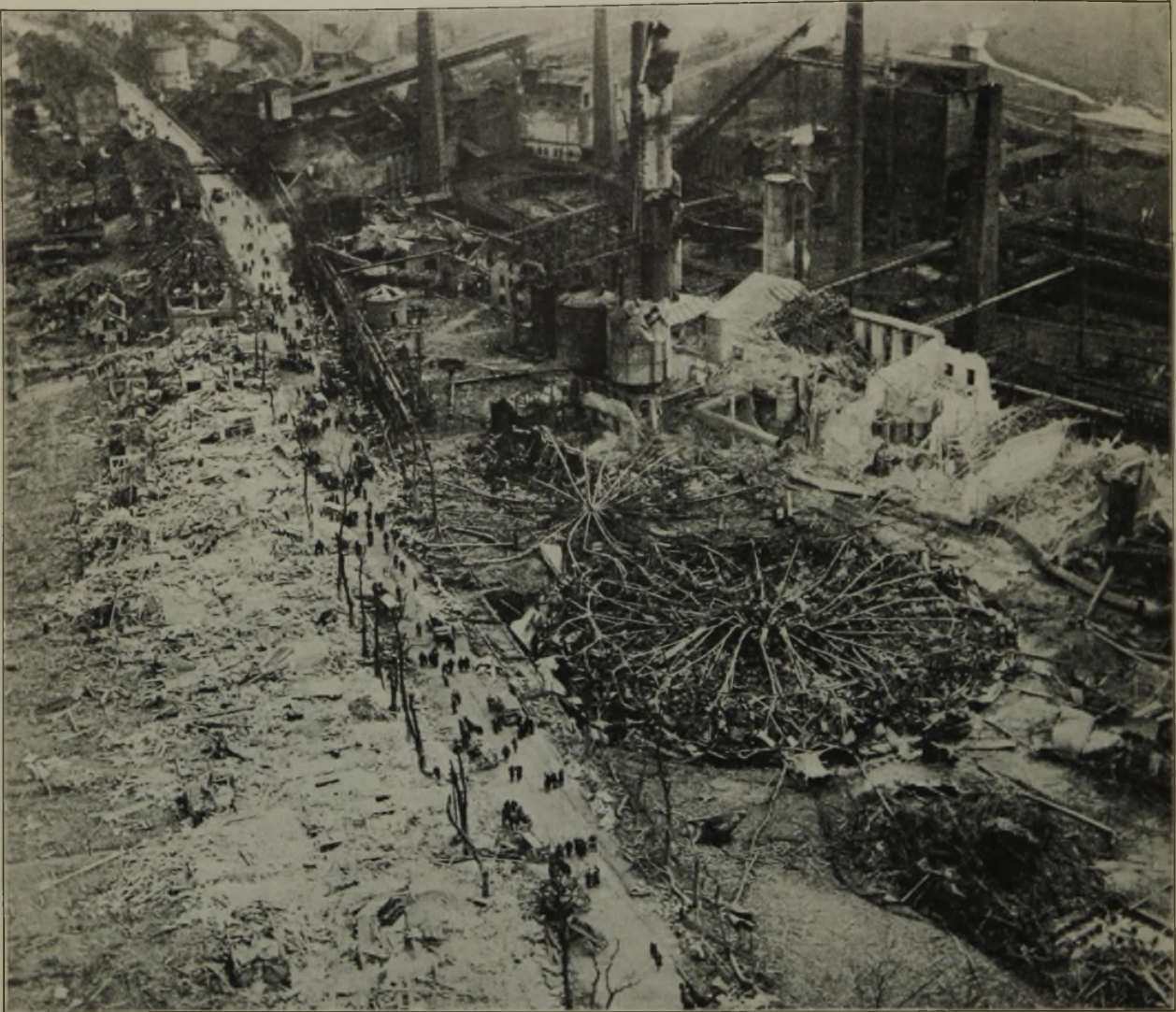
Abbildung 11. Gesamtansicht der Zerstörungen durch die Explosion. (Mit freundlicher Genehmigung der Zeitung Daily Mirror.)
