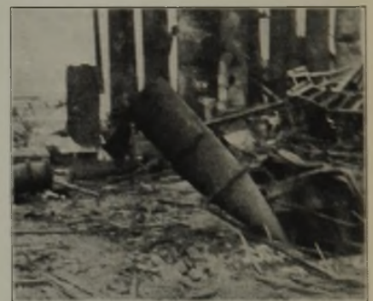
Abbildung 8. Rohr am Gasaustritt.
