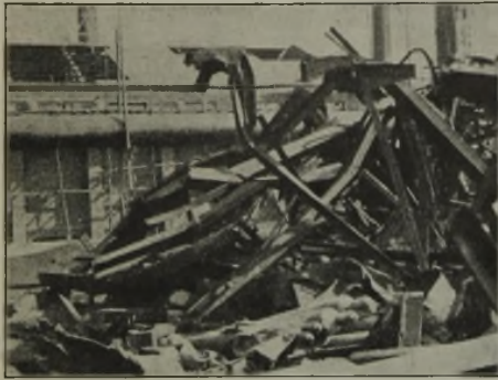
Abbildung 15. Knicung des zweiten Obergurtwinkels bei Pfosten 20 (s. Abb. 13).
