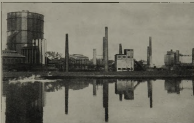
Abbildung 1. Gesamtansicht der Anlage vor der Explosion.
