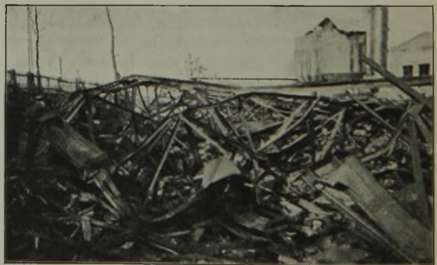
Abbildung 18. Umbruch der vorderen Dreiecke bei Pfosten 7 und 8 (s. Abb. 13).
