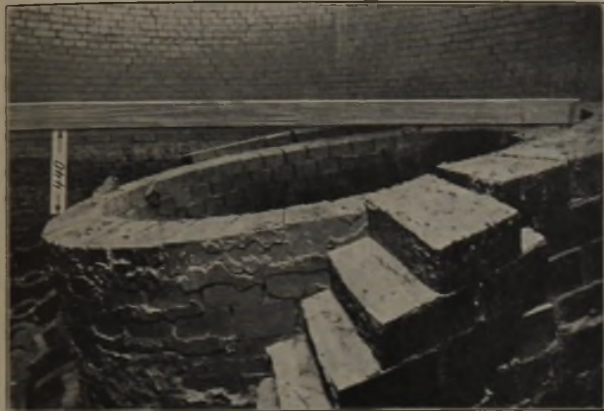
Abbildung 6. Abweichung des Winderhitzerschachtes nach 20monatiger Betriebsdauer.
