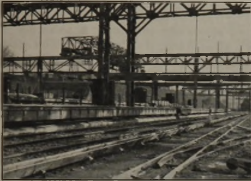
Abbildung 8. Stromzuführung an Kranfeldern.
