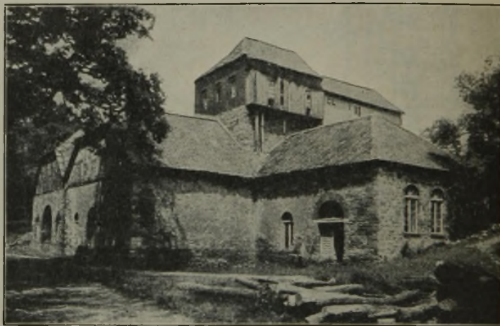
Bild 1. Louisenhütte in Wocklum. (Links: Gießerei und Gießhalle; Mitte: Hochofen; rechts: Gebläsehaus.)
