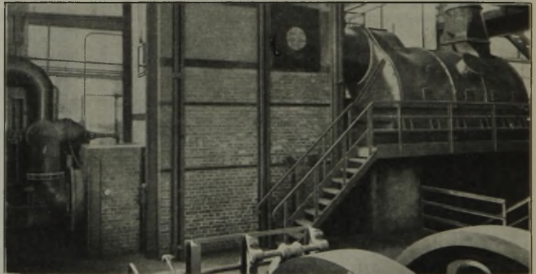
Bild 2. Brennkammer und Kontakt-Trockner.
