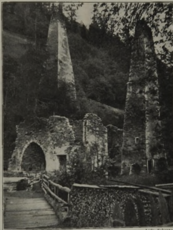
Schmelzwerk Kendlbruck im oberen Murtale. Links der Floßofen, rechts der Essenstock zweier Frischfeuer, beides aus der zweiten Hälfte des 18. Jahrhunderts. Sehr bemerkenswert ist die ganz altartige Vereinigung von Schmelzofen und Frischfeuer unter einem Dach.
