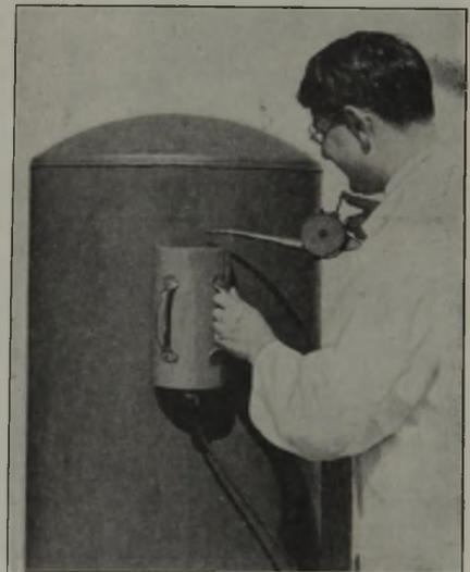
Bild 9. Tunnelmagnet zur Prüfung dünnwandiger Schweißnähte.
