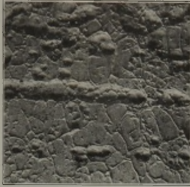
Bild 29. Lochfraß unter der Hartzinkdecke an einer Zinkkesselwand. (rd. \times 0,6 .)
