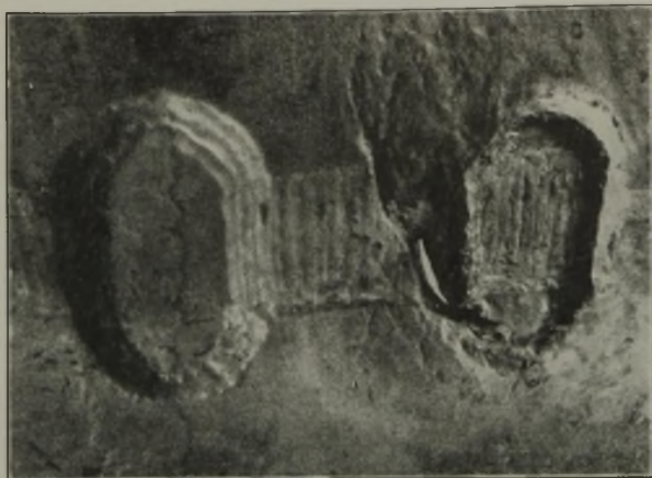
Bild 32. Leckstelle in der Schweißnaht eines Zinkkessels neben Verstärkungslasche.
