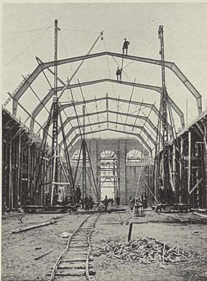
MONTAŻ KONSTRUKCJI HALI ŚRODKOWEJ BUD. Nr. 2.
