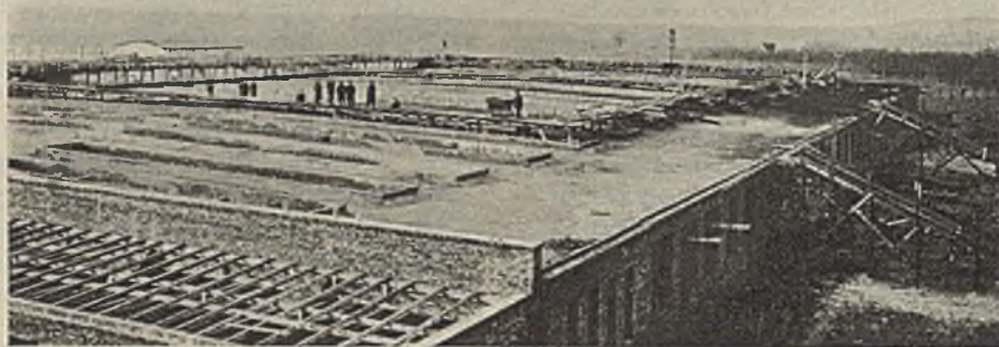
BUDOWA FABRYKI SAMOCHODÓW I ODLEWNI PÓLSZLACZETNYCH METALI DLA ZAKŁADÓW MECHANICZNYCH „URSUS” W CZECHOWICACH.
