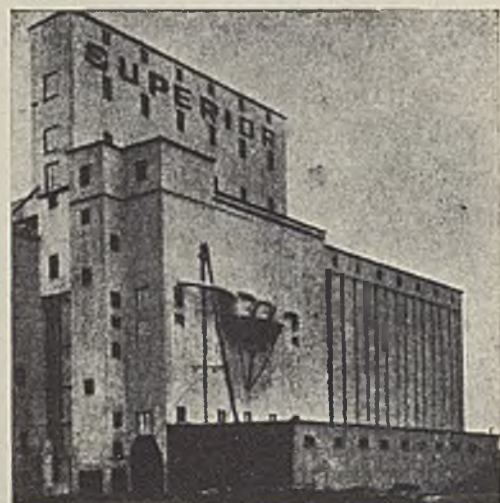
ELEWATOR W BUFFALO.
