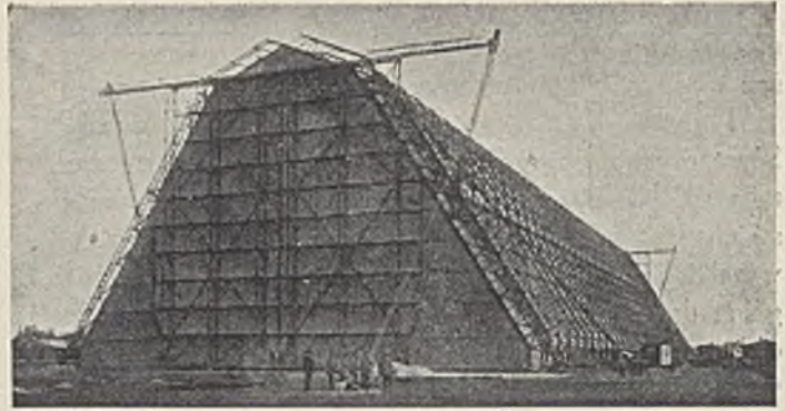
HANGAR DLA STEROWCÓW W SAARBRÜCKEN. ZBUDOWANY W 1915 R. PRZEZ PRUSKIE M. S. WOJSK. Montaż i rozbiórka hangaru dokonywuje się w ciągu miesiąca. Długość hali 180 mtr., szerokość i wysokość 30 mtr.
