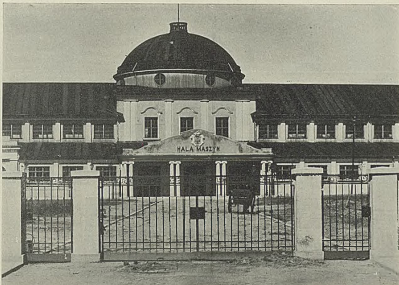
MIEJSKI WYDZIAŁ BUDOWLANY W POZNANIU, pod kier. ARCH. KAZIMIERZA RUCIŃSKIEGO. HALA MASZYN NA TARGACH POZNAŃSKICH. Fragment centralny z głównym wejściem.
