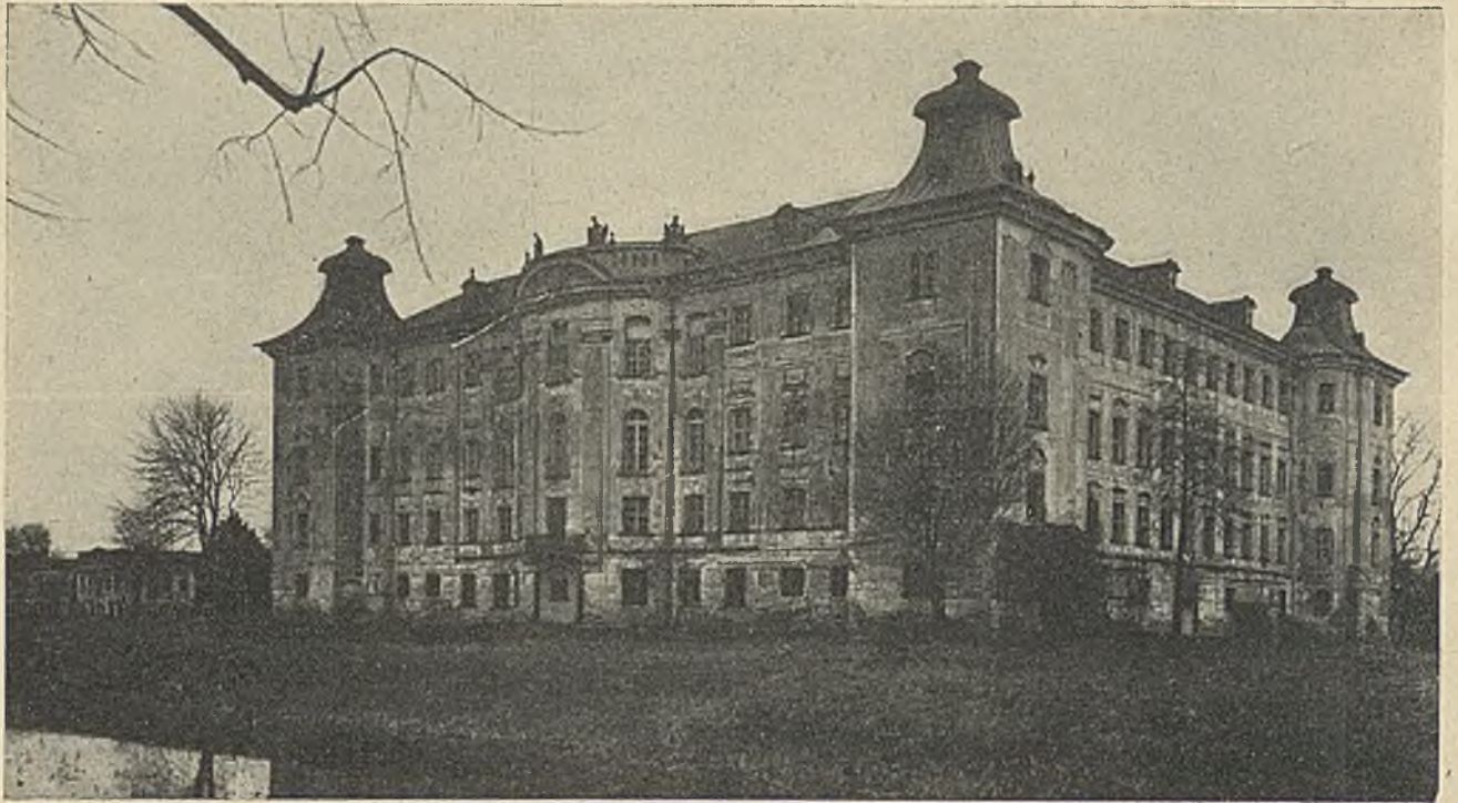
Ryc. 31. RYDZYNA. ZAMEK. Widok od strony zachodniej.
