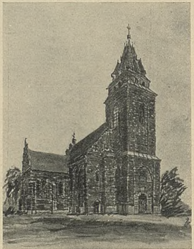
ARCH. BRUNO ZBOROWSKI (WARSZAWA). PRZEBUDOWA KOŚCIOŁA W RÓŻANACH.
