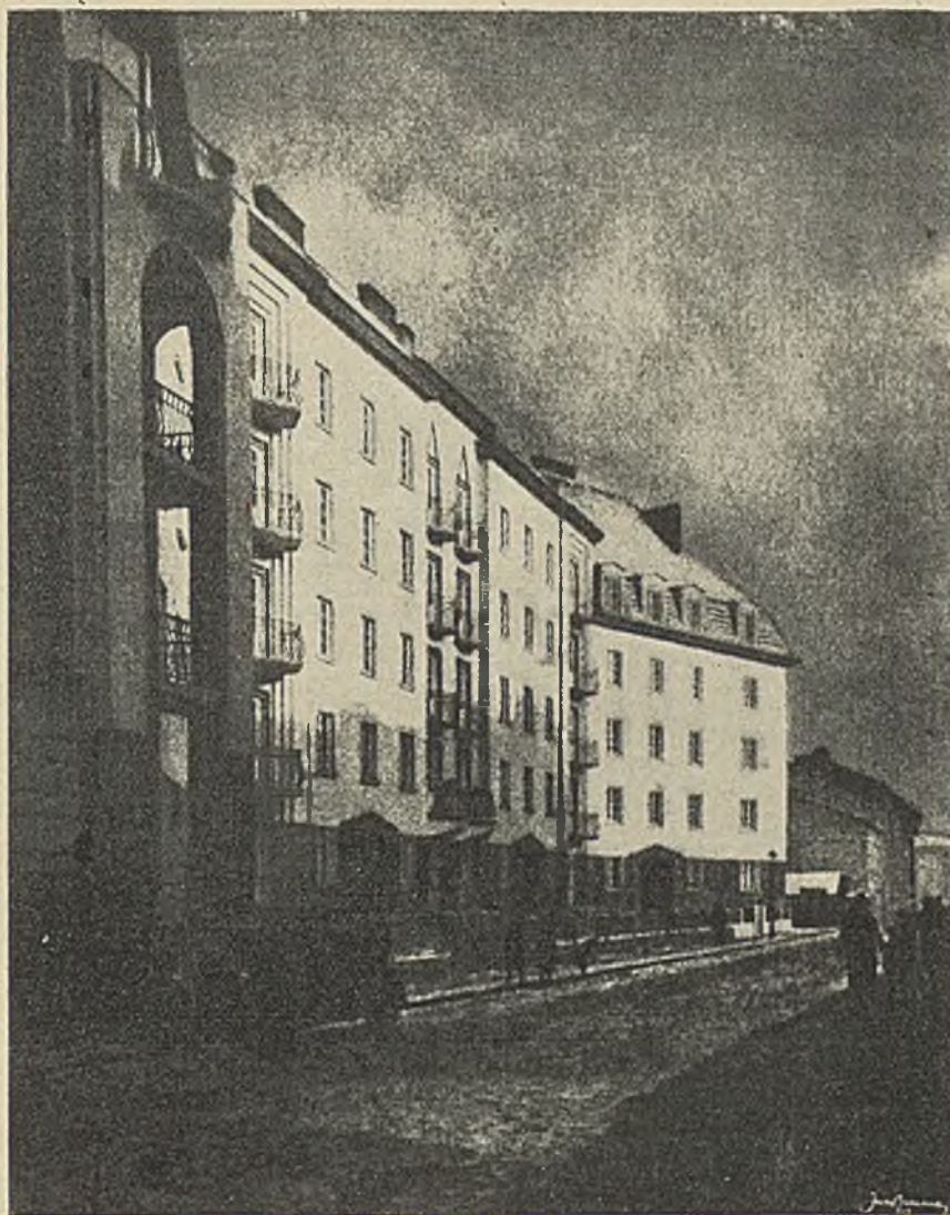
ARCH. WITOLD MINKIEWICZ (LWÓW). DOM CZYNSZOWY ZAKŁADU PENSYJNEGO DLA FUNKCJONARIUSZÓW WE LWOWIE PRZY UL. „NA BAJKACH”. Fot. J. Nauman.
