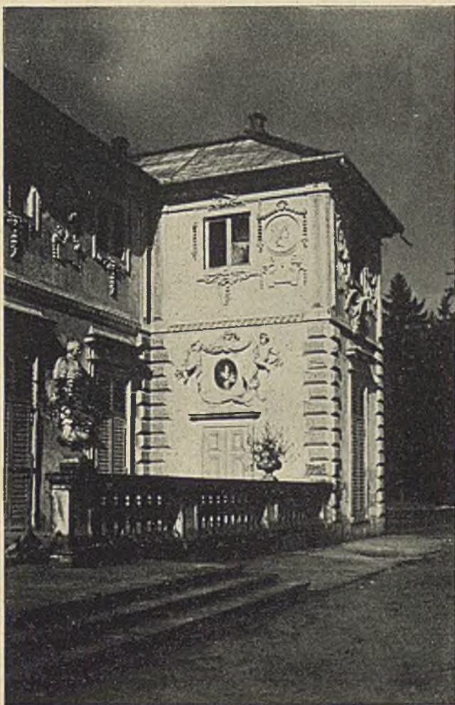
FIG. 16. PAWILON NAROŻNY OD STRONY PARKU Architektura z czasów Sobieskiego
