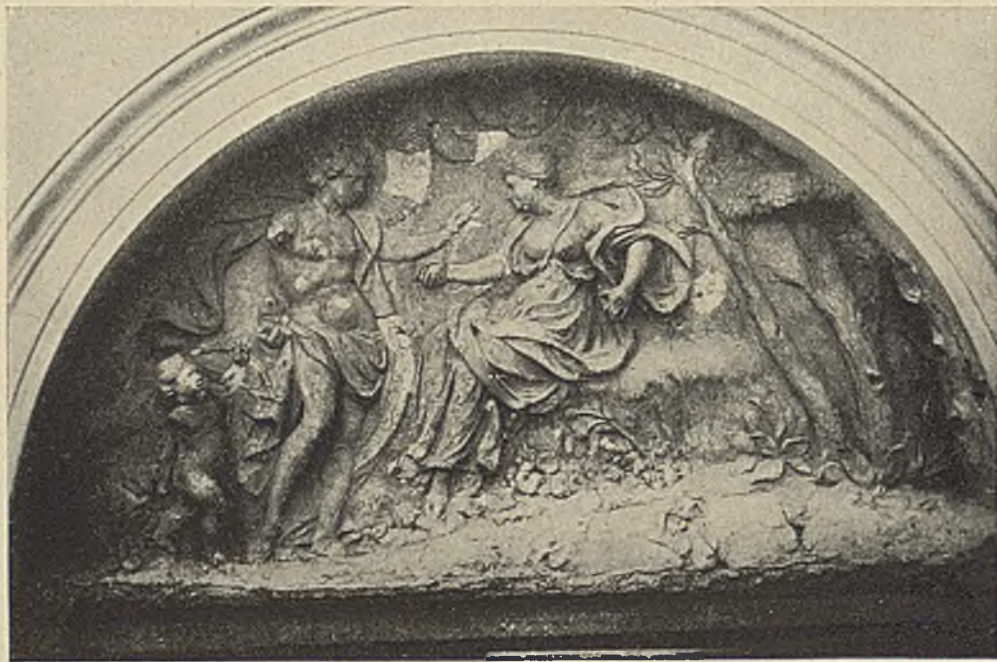
FIG. 34 i 35. PŁASKORZEŻBY W ŁUKACH ARCHIWOLT LEWEGO SKRZYDŁA PALACU Stan przed konserwacją
