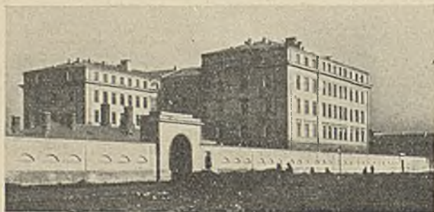
Fragment Oficerskiej Szkoły Inżynierskiej. Budowa wykonana przez firmę „Żelazo-Beton“
