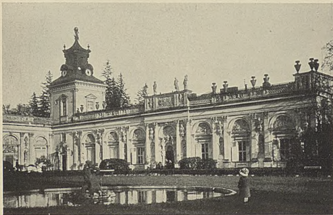
FIG. 33. PRAWY SKRZYDŁO PALACU Stan przed restauracją z dachem, opartym na balustradzie i z wazonami i blaszanymi
