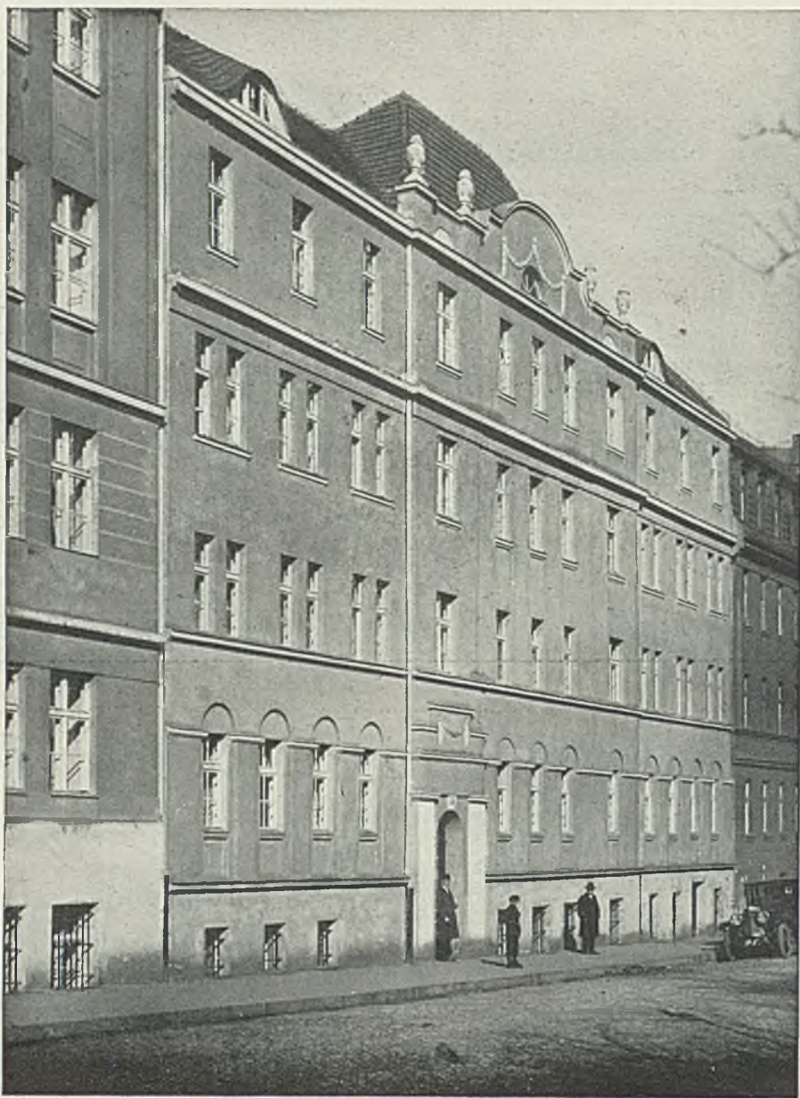
Miejski Urząd Bud. Nziemnego w Poznaniu. Arch. Kazimierz Ruciński i Jerzy Tuszowski (Poznań). Dom dla samotnych przy ulicy Rybaki
