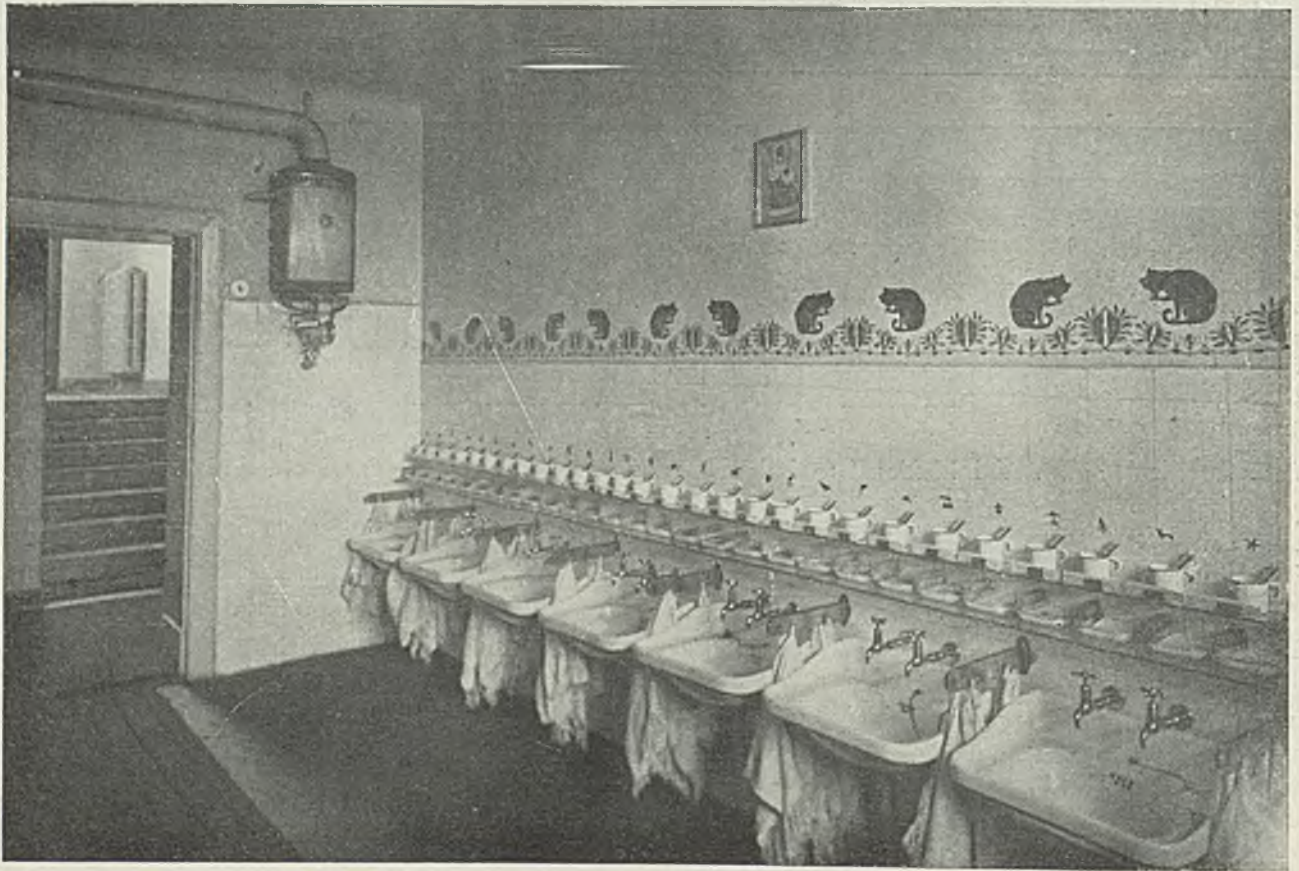
Ryc. 15 i 16. Arch. Adam Ballenstedt (Poznań), Domy Poznańskiej Kolei Elektrycznej w Poznaniu. Ochronka.
