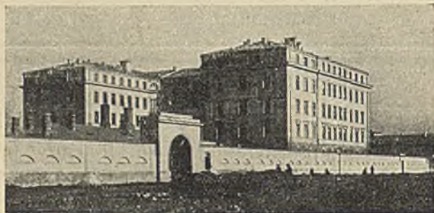
Fragment Olicerskiej Szkoły Inżynieryjnej. Budowa wykonana przez firmę „Żelazo beton”
