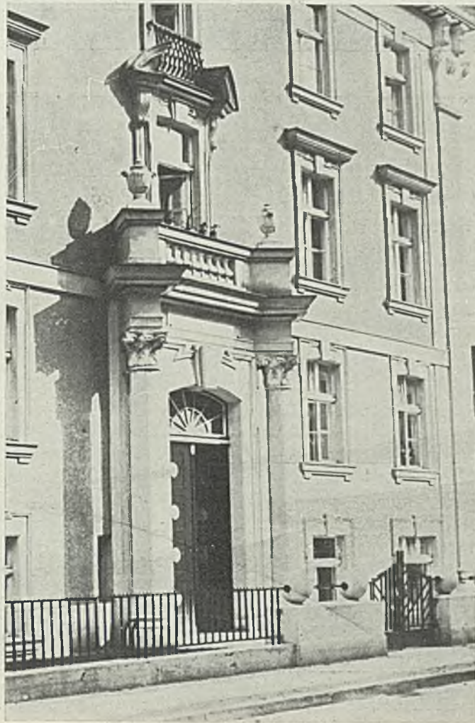
Ryc. 2. Portal bocznej oficyny od ul. Kochanowskiego.
