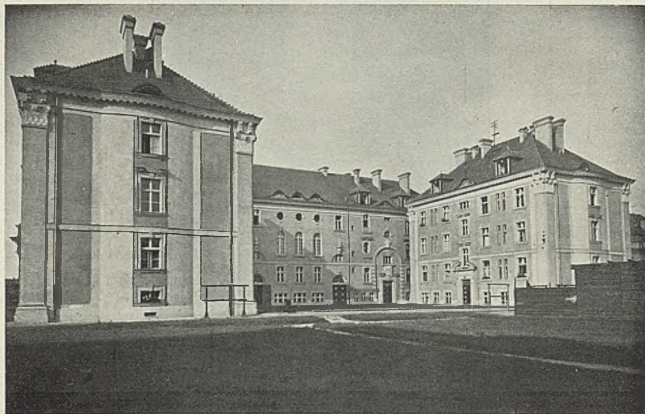
Ryc. 3 i 4. Arch. Adam Ballenstedt (Poznań). Domy Poznańskiej Kolei Elektrycznej w Poznaniu. Widok od strony dziedzińca.
