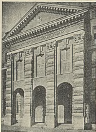
Fragment fasady Państwowego Banku Rolnego Arch. Prof. M. Lalewicz „TERRAZYT“ w połączeniu z piaskowcem.
