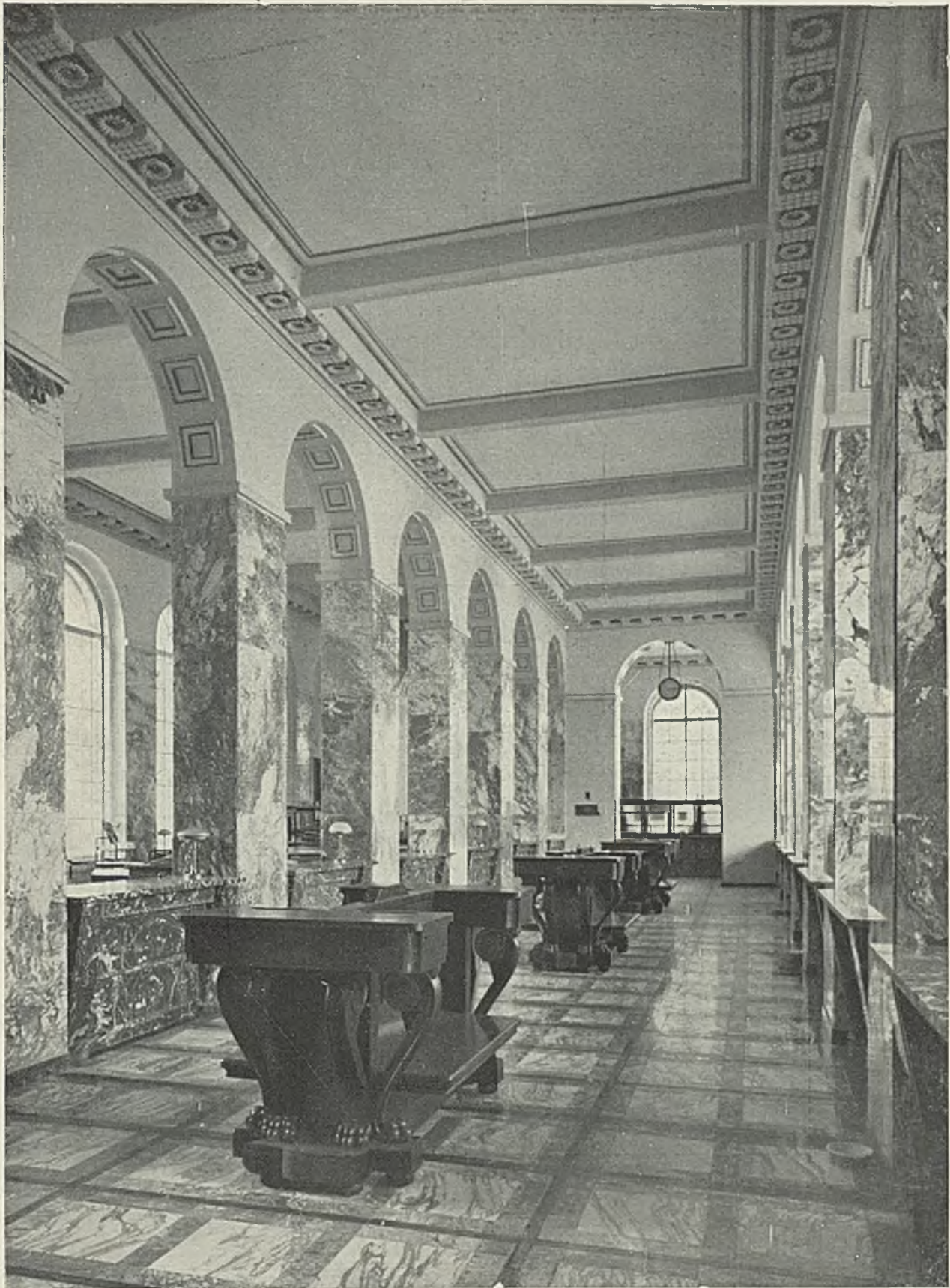
Ryc. 12. Arch. Marjan Lalewicz (Warszawa). Gmach Państwowego Banku Rolnego w Warszawie. Sala bankowa parteru.
