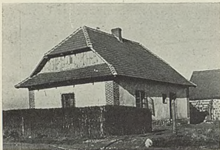
Domek z gliny na szkielecie murowanym. Kubatura — 310 m 3 , koszt budowy 3.500 zł. Budynek inwentarski z kamienia polnego.
