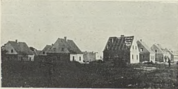
Ryc. 24—26. Ogólny widok zabudowań osad rybackich na Helu.
