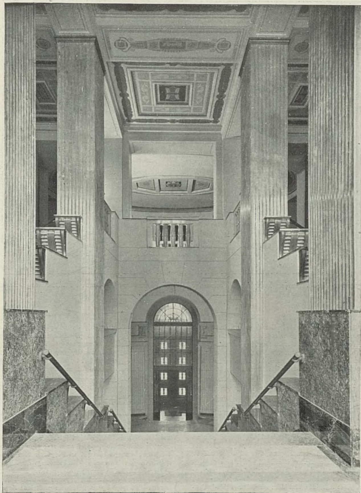
Ryc. 20. Arch. Marjan Lalewicz (Warszawa). Gmach Państwowego Banku Rolnego w Warszawie. Główna klatka schodowa. Wyprawa hallu wykonana zaprawą „Terrazyt” Zakładów Przem. „Terrazyt” w Warszawie. Konstrukcje żelazobetonowe, stiuki i sztukaterję wyk. firma „Paweł Holc i S-ka”. Konsolle mosiężne i poręcze wyk. firma „H. Zieleziński” w Warszawie.
