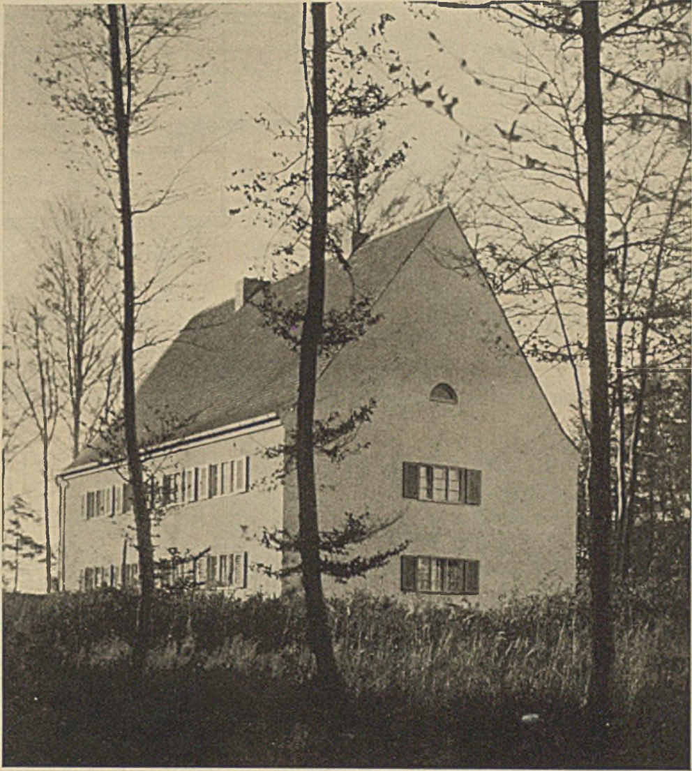
Vierfamilien-Wohnhaus der Postbaugenossenschaft in Sarnberg Entwurf und Bauleitung Oberpostdirektion München
