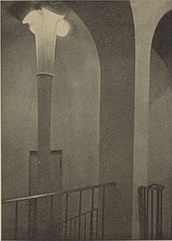
Innsbrucker Kasino. Blick von der Brücke in die Diele Pfeiler mit indirekter Beleuchtung
