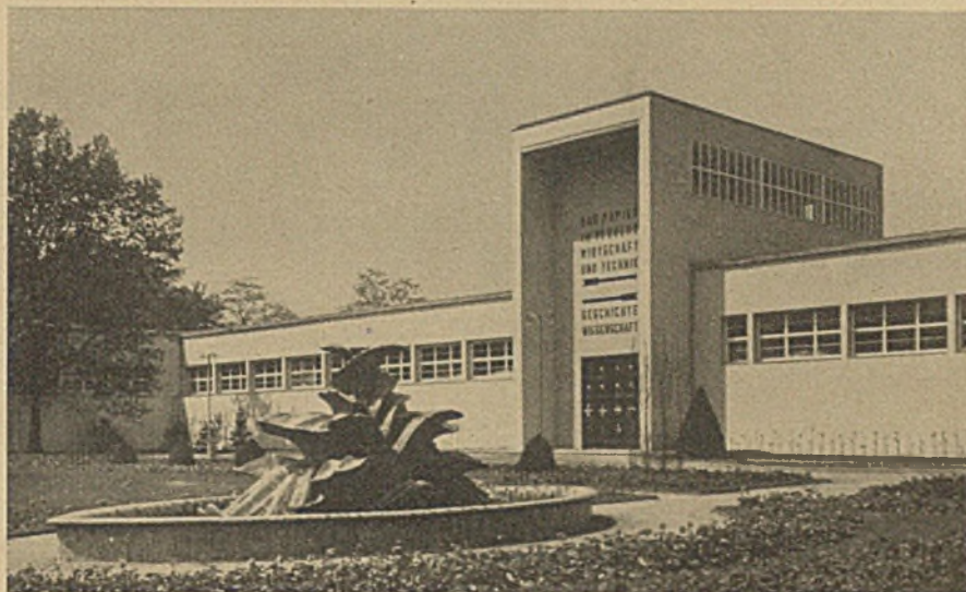
Hallenhof der geschichtlich-wissenschaftlichen Abteilung Architekt Hans Richter Brunnen von Prof. H. Poelzig (1922)
