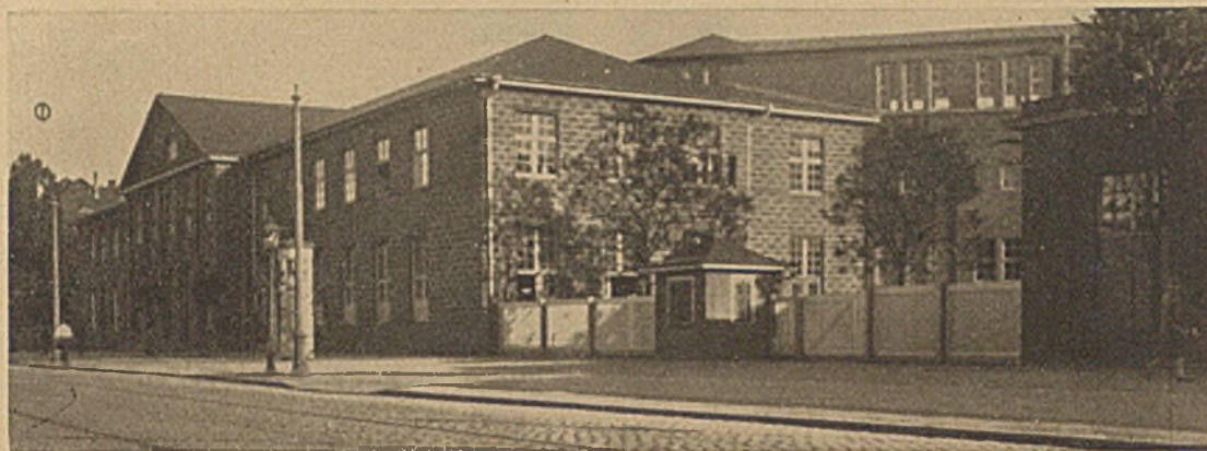
Verwaltungsgebäude des Messeamtes in Frankfurt a. M. in Schlackenblocksteinen mit verputzten Sichtflächen (ohne Verputz)
