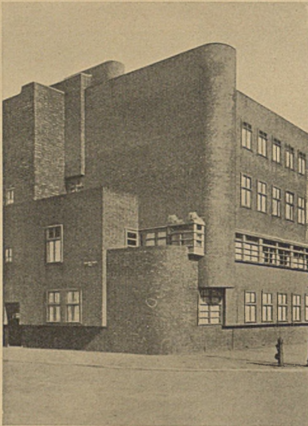
Wohnhäuser in Amsterdam, Arch. J. F. Staal
