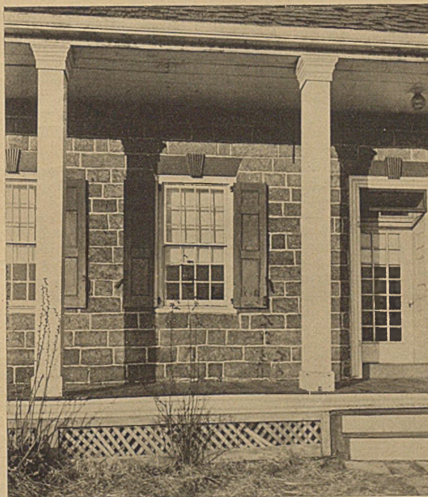
Teil von Westerveldt-Haus. Tenaffly, N.J.
