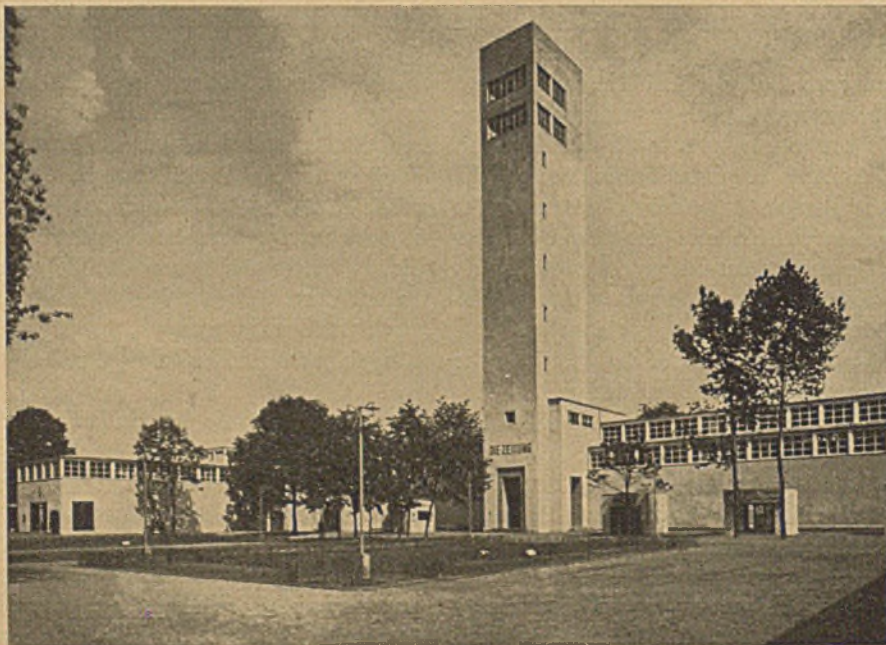
Dresden hat für die diesjährige Ausstellung „Das Papier“ einen „sprechenden Turm“ von 46 m Höhe erbaut
