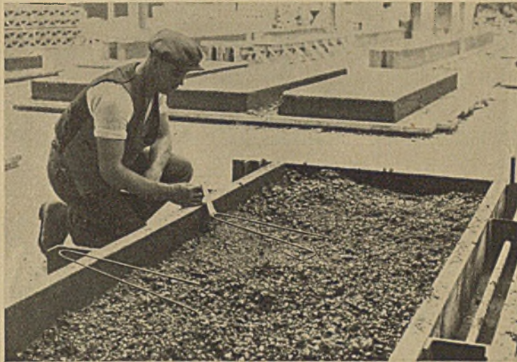
Einlegen der Rundeisenhaken in die Plattenform
