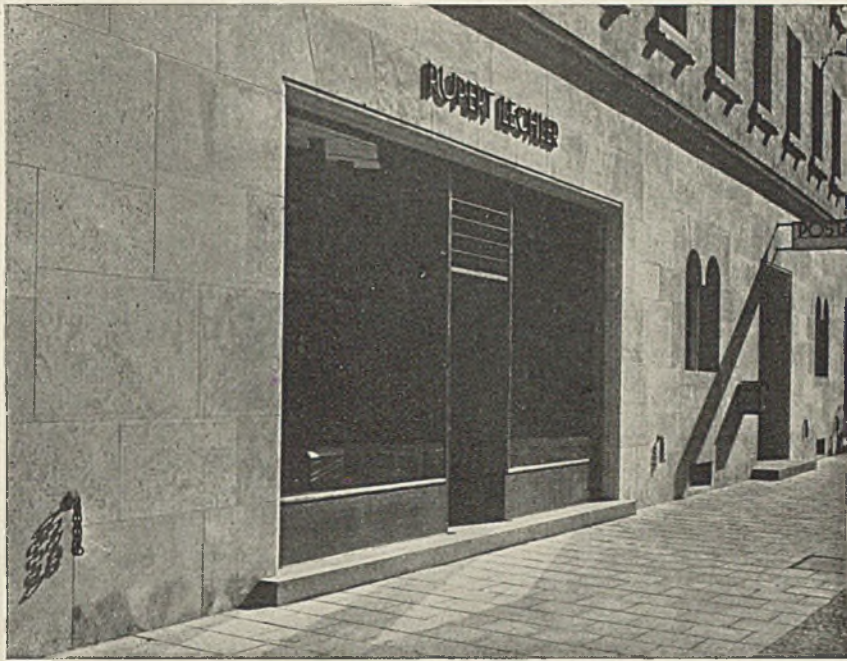
Der Sockel im Streiflicht, Wirkung von Material, Fugenschnitt und Profilen
