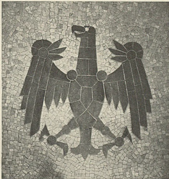
Fußboden in der Vorhalle, Mosaik, aus Solnhofener Plattenstückchen, mit ausgelegtem Adler aus Platten von belgischem Granit, geschliffen und gewachst
