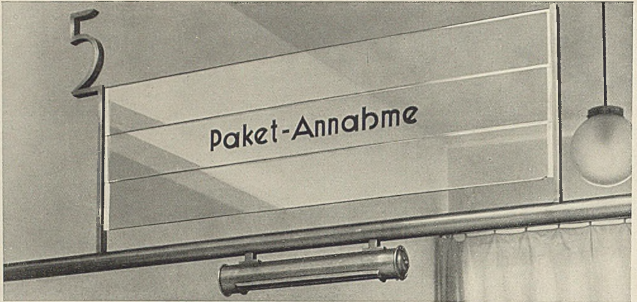
Schalteraufschrift auf auswechselbaren Spiegelglasstreifen, die auf Duranarrohr aufmontiert sind, in welchem die Lichtleitung liegt; verdeckte Beleuchtung (Der Vorhang ist rückwärts am Fenster)
