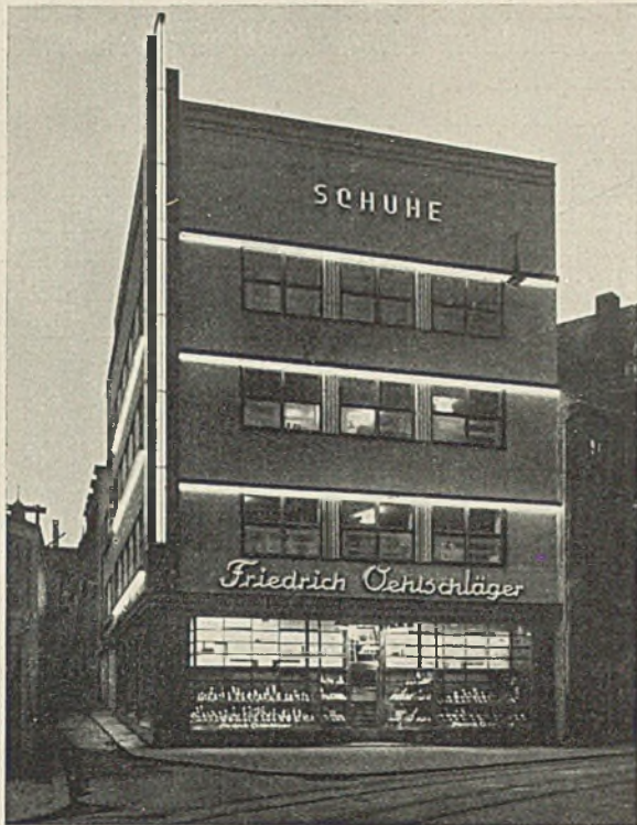
Betonung von Architekturteilen (Hersteller A.-G. für Elektrizitäts-Industrie in Leipzig)
