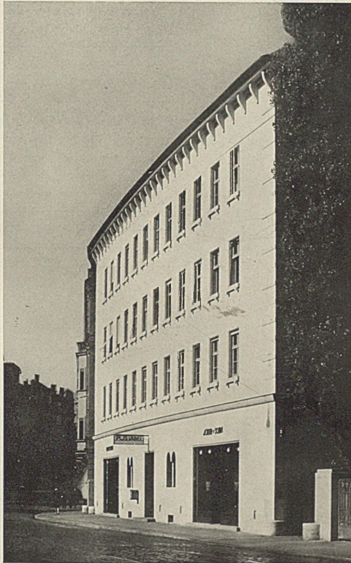
POSTAMT AN DER GALERIESTRASSE IN MÜNCHEN
