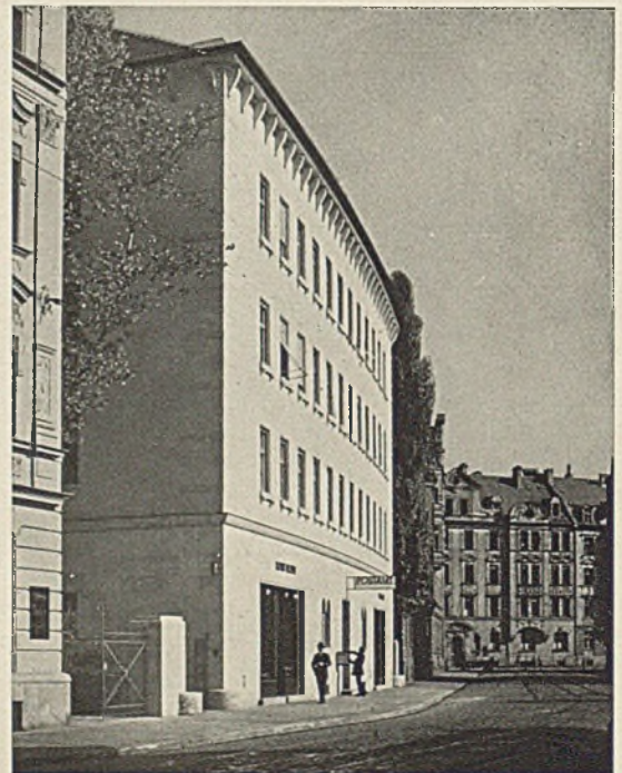
Ansicht von der Ludwigstraße her Die Hauswand ist entsprechend der Straßenführung gekrümmt Die Wirkung der Profile, des Materials usw. kann in den Einzelheiten (Seite 368-376) nachgeprüft werden
