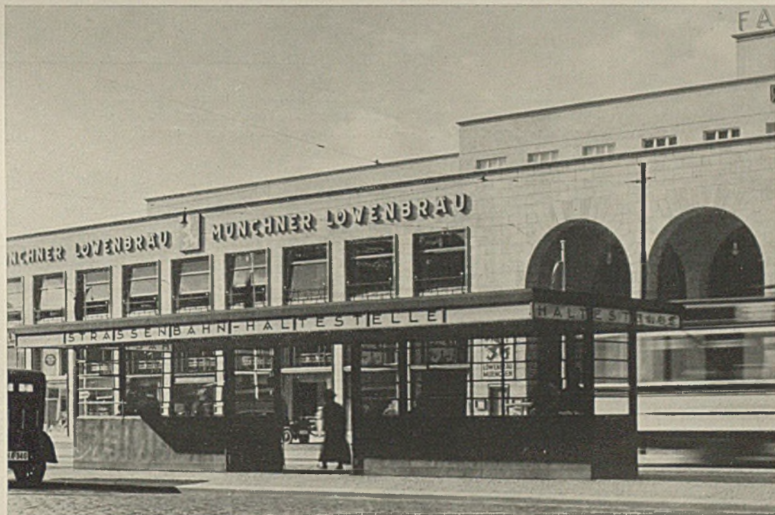
Wartehalle der Straßenbahn vor dem Hauptbahnhof in Stuttgart Ganz in Metall, verkupfert, Sprossen und Rahmen um die Schriften grau gestrichen. Decke ebenfalls grau. Spiegelglas. In der Mitte ein Durchgang, seitlich Holzbänke.
