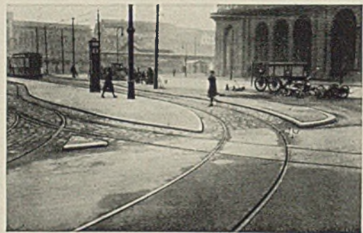
Straßenbahnhaltestellen am Görlitzer Bahnhof in Berlin (Normalspurgeleise!) Nov. 28
