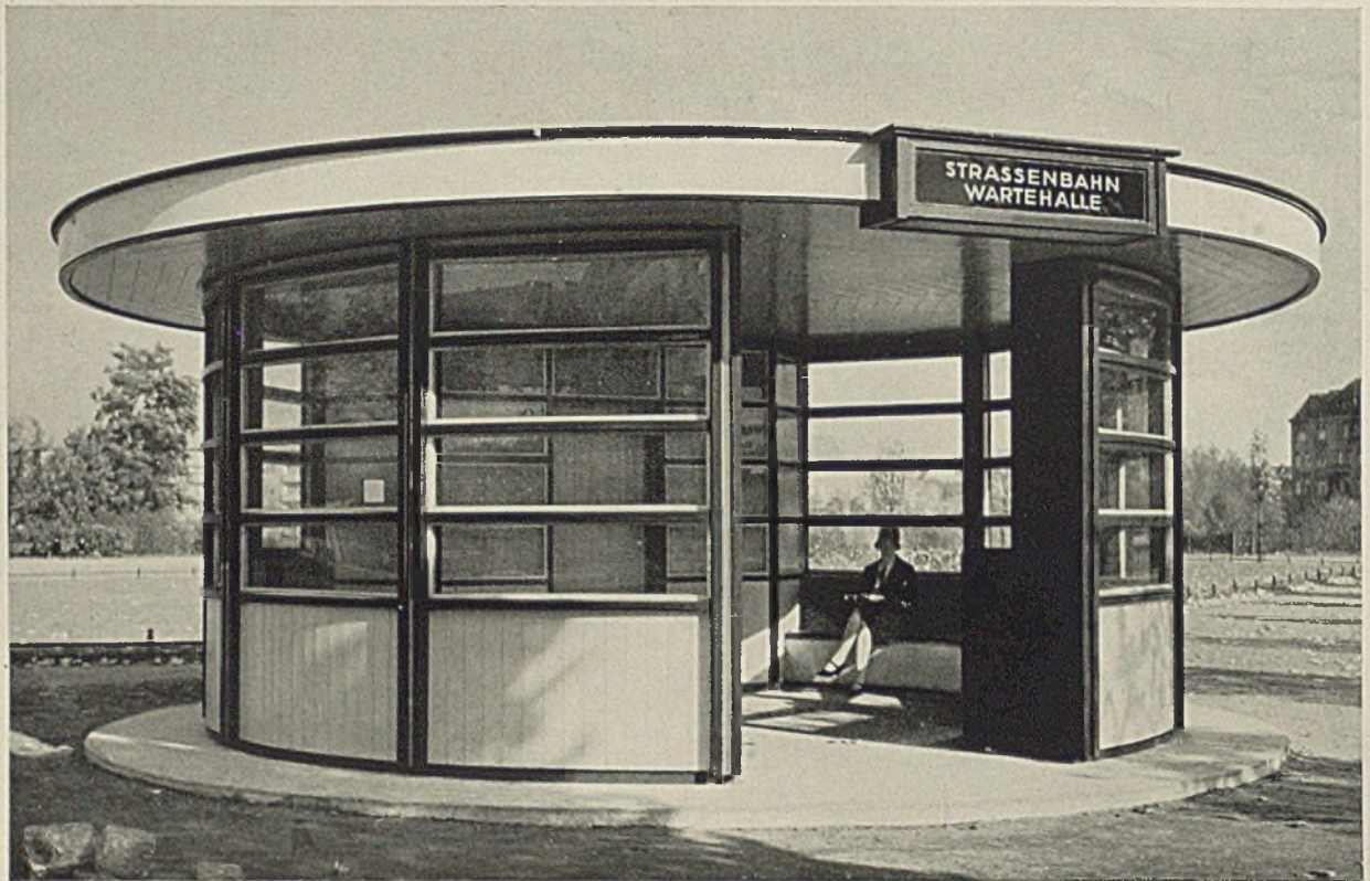
Straßenbahnwartehalle Fehrbelliner Platz in Berlin (hierzu Tafel 55-56)
