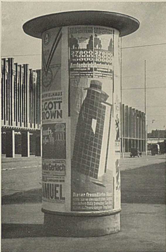
Litfaßsäulen in Köln und Stuttgart mit niedrigem, unauffälligem oberem Abschluß — Rechts Plakatsäule in Stuttgart (aus drei dünnwandigen Betonringen)
