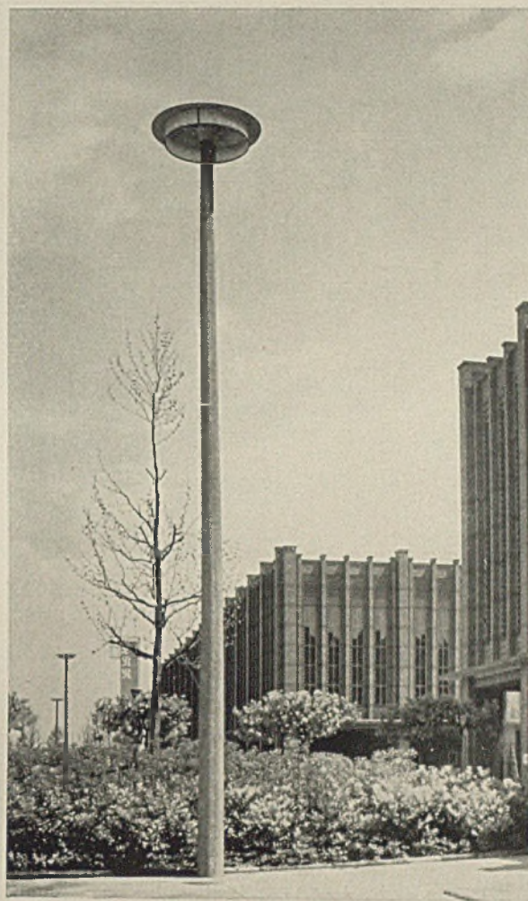
Großer Beleuchtungsmast — Städt. Hochbauamt Köln Entwurf Stadtbaurat Mehrrens
