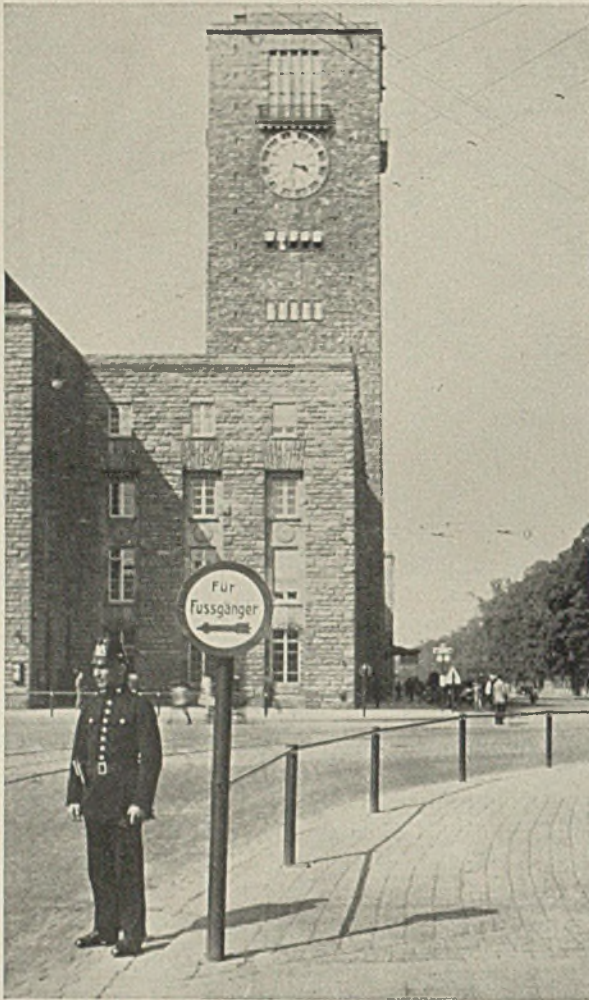
Links Eiserne Verkehrsschranken. Die horizontalen Stangen und der Kopf der Pfosten rot, darunter weißer Ring. Die Pfosten grau. Alles entfernbar. (Entwurf Stadterweiterungsamt Stuttgart) — Rechts Haltestelle der Kraftwagenlinien
