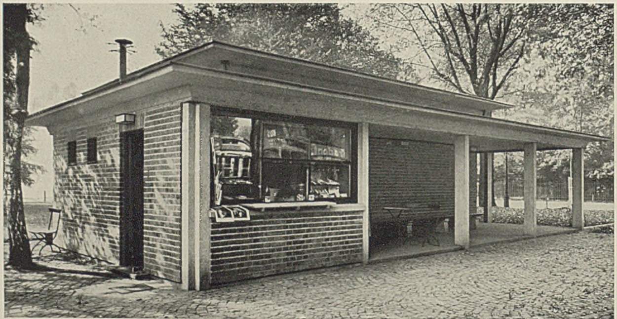
Schaltheus mit Wartehalle und Laden in Köln-Marienburg — (Städt. Hochbauamt) Entwurf Baurat Nolte
