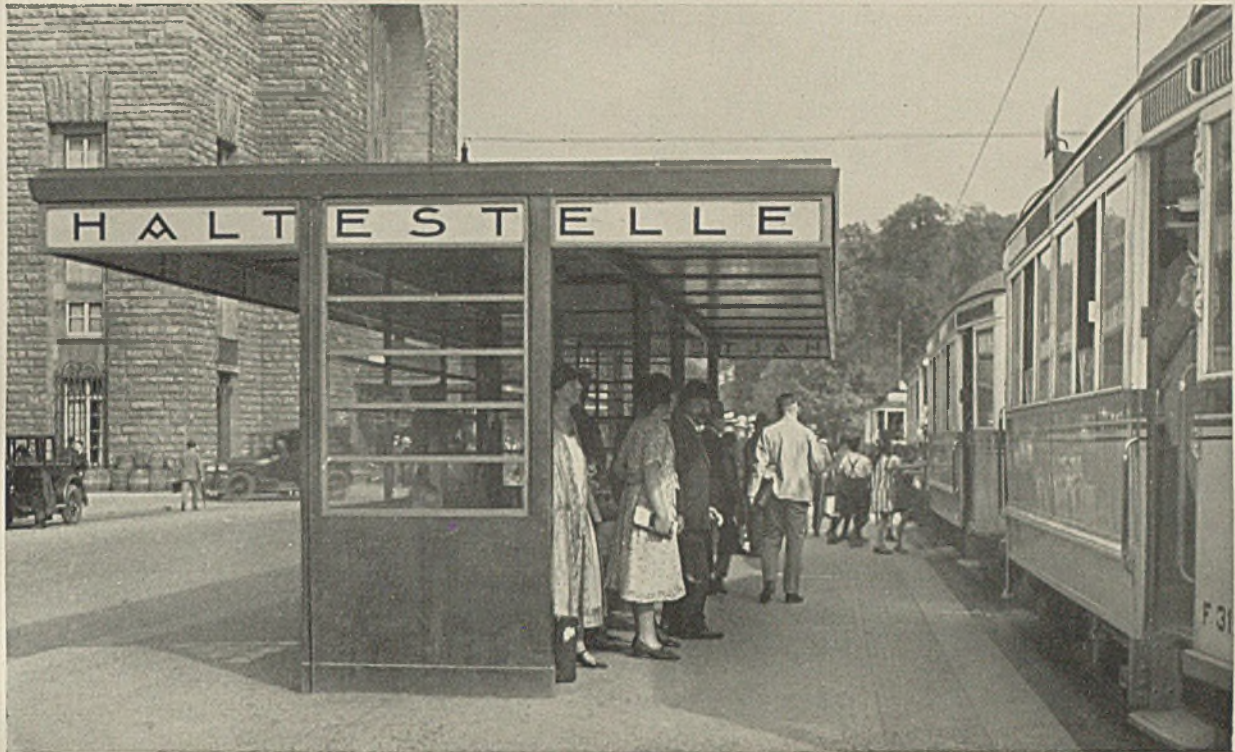
Wartehalle der Straßenbahn vor dem Hauptbahnhof in Stuttgart Ganz in Metall, verkupfert, Sprossen und Rahmen um die Schriften grau gestrichen. Decke ebenfalls grau. Spiegelglas. In der Mitte ein Durchgang, seitlich Holzbänke.
