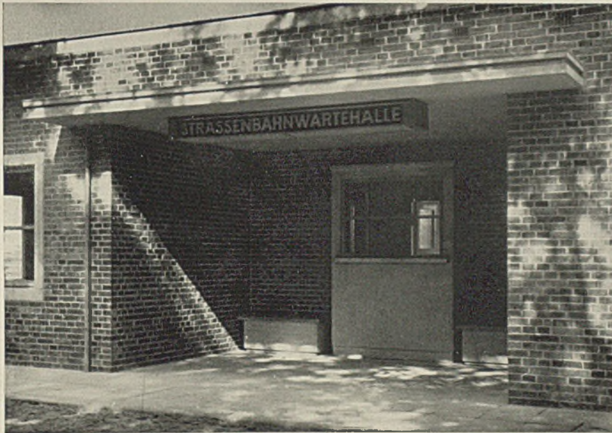
Gedeckter, halboffener Warteraum
