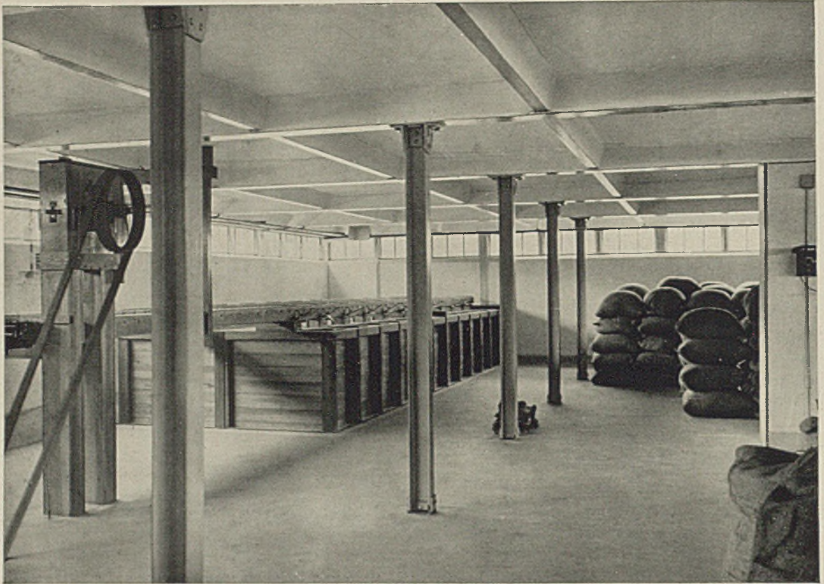
Oberstes Halbgeschoß mit Dachuntersicht
