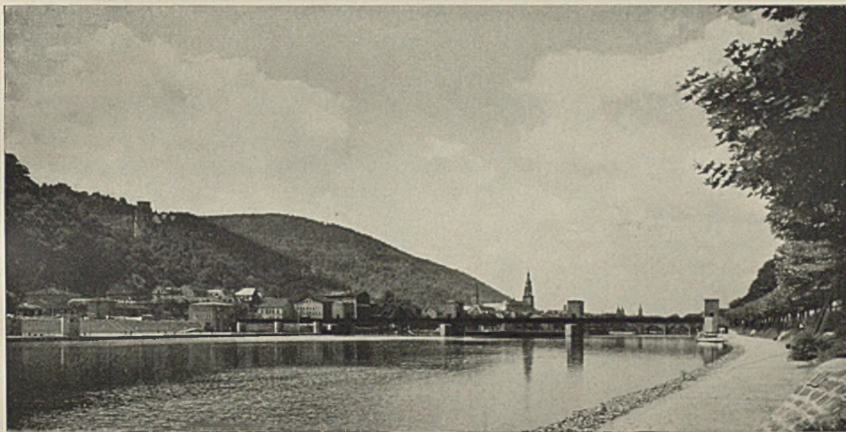
Stauwehr Heidelberg. Entwurf Neckarbaudirektion Stuttgart, Mitarbeiter als Architekt P. Bonatz-Stuttgart (Die Lichtbilder der Staustufe Heidelberg sind von Photograph F. Fels-Stuttgart) Auf dieser Aufnahme kommt die Einfügung der Wehrbauten in eine historische Landschaft (links oben das Heidelberger Schloß) zur Geltung. Baujahr 1928—29.
