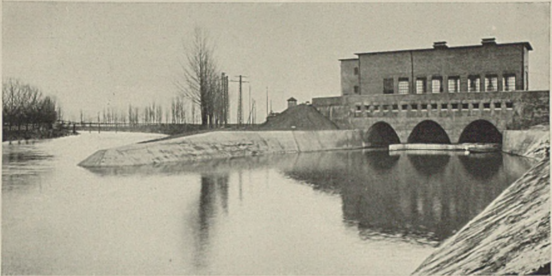
Kraftwerk der Staustufe Obereßlingen am Neckar. Baujahr 1928 Entwurf Neckarbaudirektion Stuttgart, Mitarbeiter als Architekt P. Bonatz-Stuttgart
