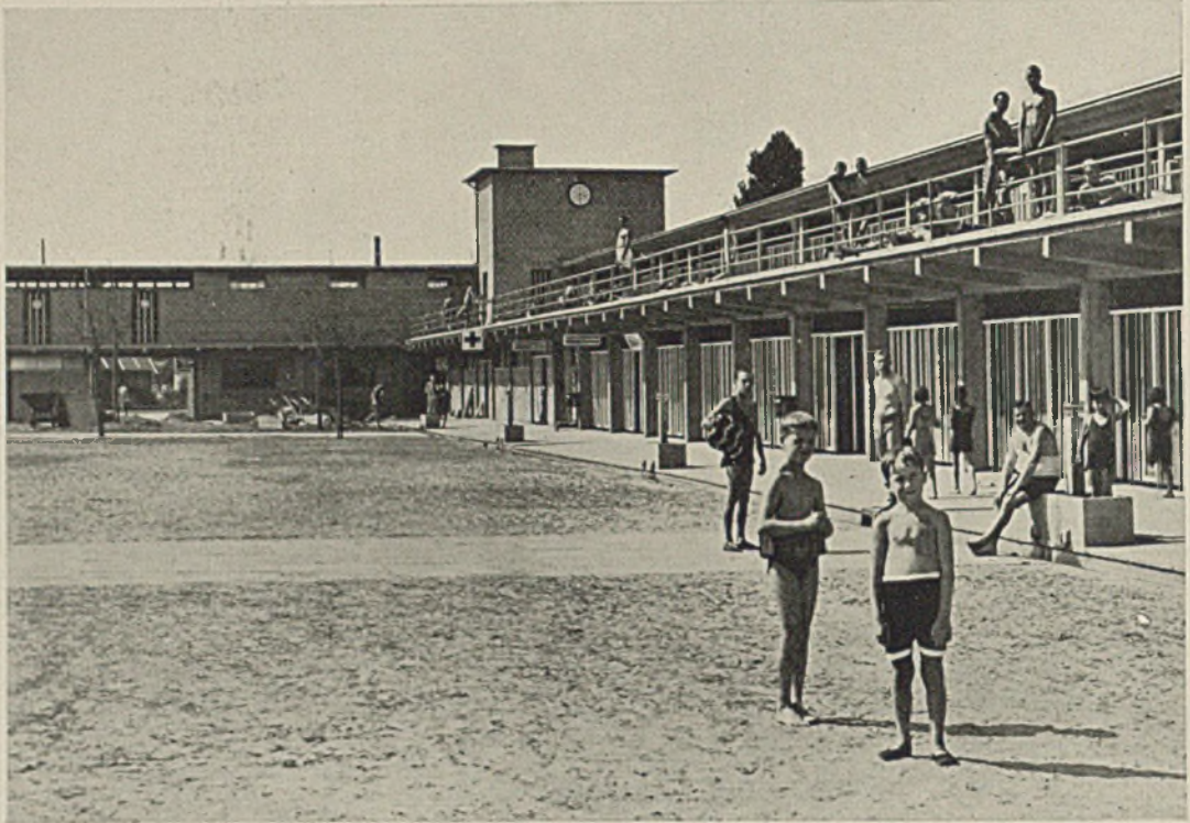
Auskleidezellen im Inselbad Untertürkheim, Stuttgart. Unten sind die Wechselzellen (Massengarderobe), oben die Einzelzellen untergebracht. Durch Flachdach und Balustrade ist der lange Zellentrakt gut an die übrigen Baulichkeiten angeschlossen.
