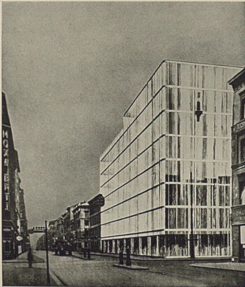
Oben Geschäftshaustyp mit vorkragenden Betonplatten und durchlaufenden Fensterbänken Unten Geschäftshaustyp mit durchgehender Glaswand. Entwürfe von Mies van der Rohe, (Aus: „Glas am Bau und als Gebrauchsgegenstand“ von A. Korn, Verlag E. Pollak, Berlin.)
