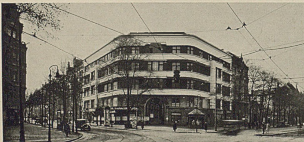
Umbau Scharlachberghaus, Kurfürstendamm (Ecke Uhlandstr.)
