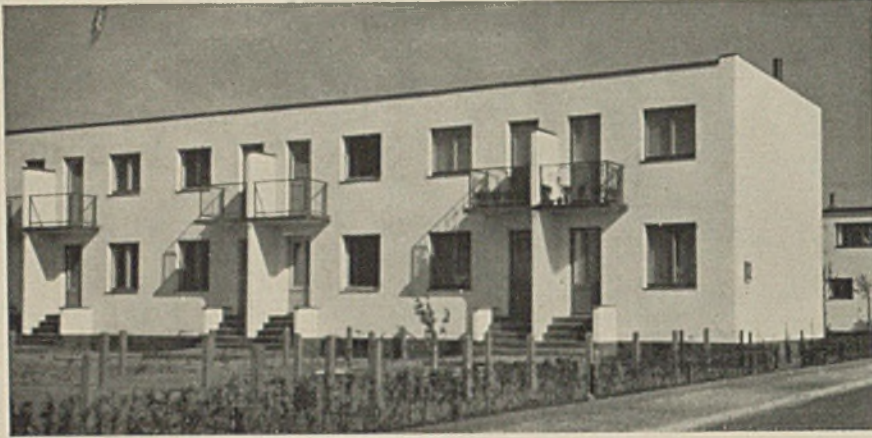
Gruppe 12 Einfamilienhäuser von Rösiger, Karlsruhe. Von Westen gesehen. Rückseite gegen den Hausgarten.
