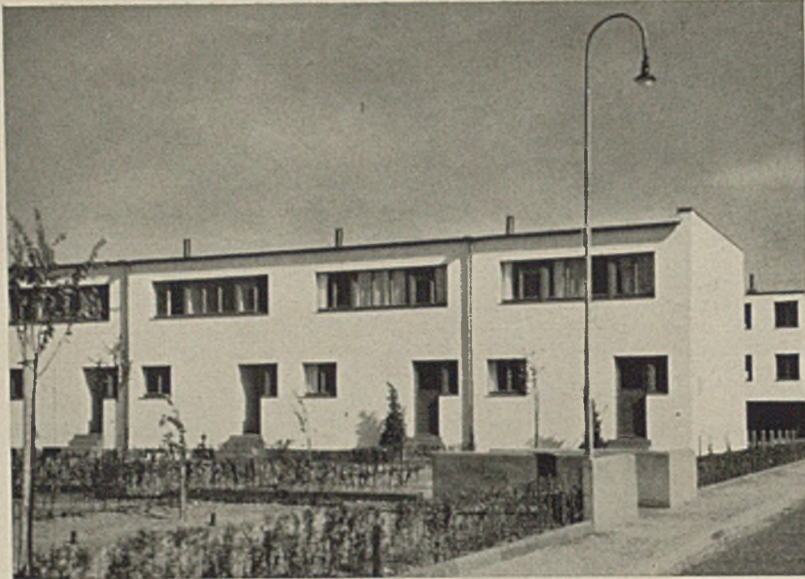
Gruppe 10: Einfamilienhäuser von Lochstampfer-Karlsruhe. Von Westen gesehen, Vorderseite gegen den Wohnweg.
