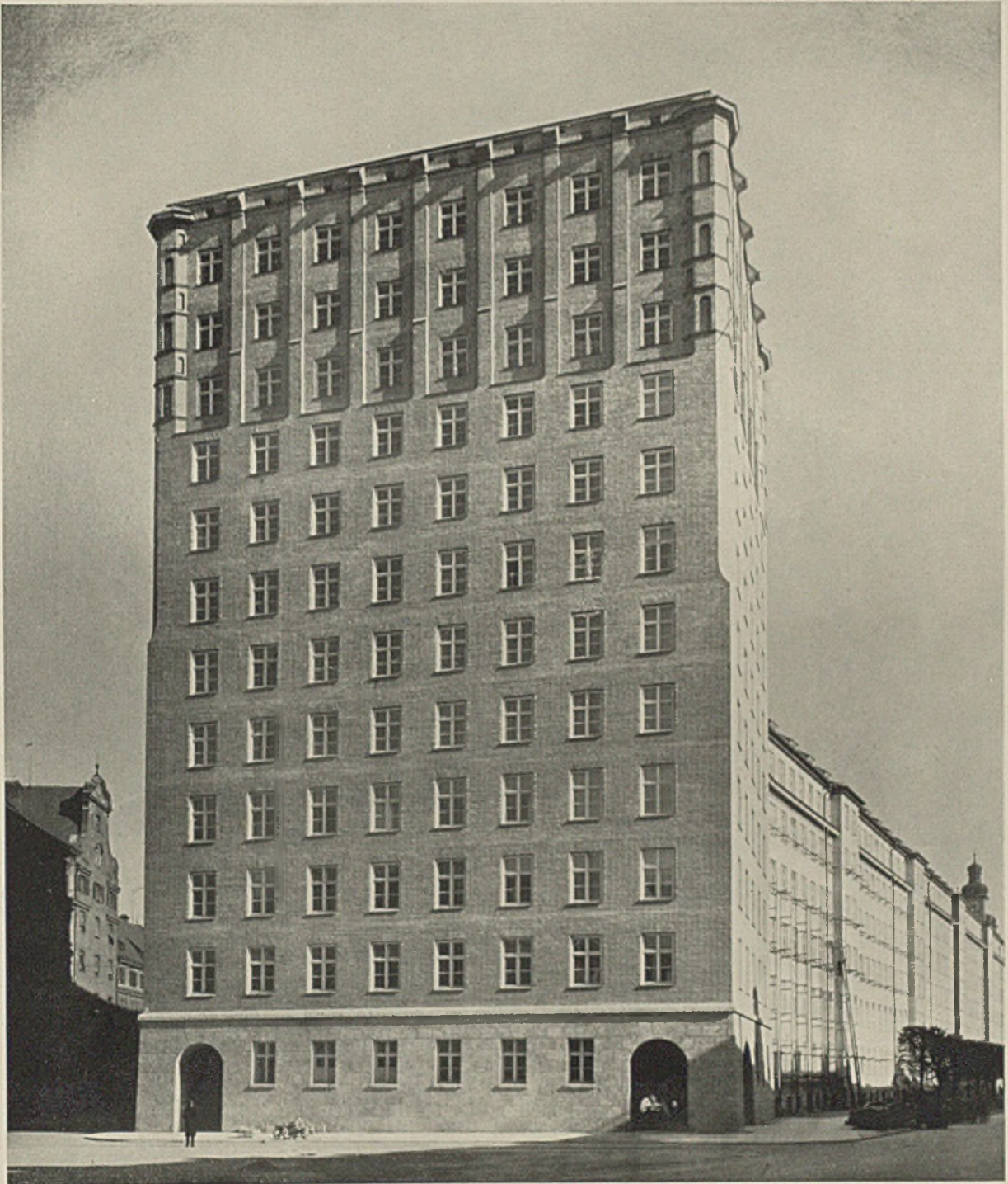
Das neue Technische Rathaus in München, am Unteranger, von Süden aus Höhe des Turmes mit 11 Obergeschossen 45 m, Breite 29\frac{1}{2} m, Länge des Bürohauses an der Blumenstraße (rechts im Bild) 156 m, am Unteranger (links im Bild) 136 m. Im ganzen stehen ca. 1000 Büroräume zur Verfügung.
