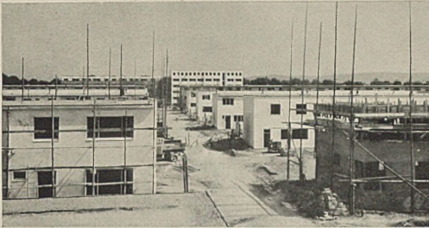
Die Eugen-Geck-Straße während des Baues.
