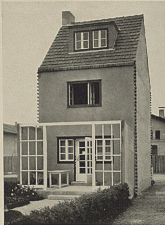
Ansicht von der Gartenseite mit wind- und blickgeschützter Wohnlaube im Freien. Normale Satteldachausbildung mit ausgebautem Dachgeschoß. Die Dachkammern sind mit 7 cm starken Heraklithplatten isoliert.
