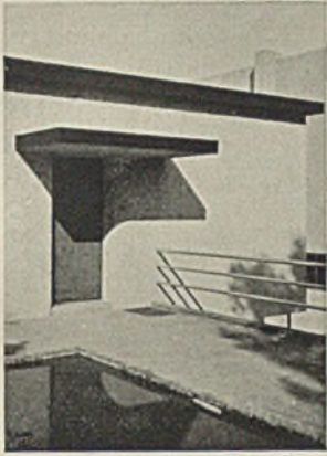
Eigenhaus des Architekten H. L. de Kooninck-Brüssel Eingang von der Straße
