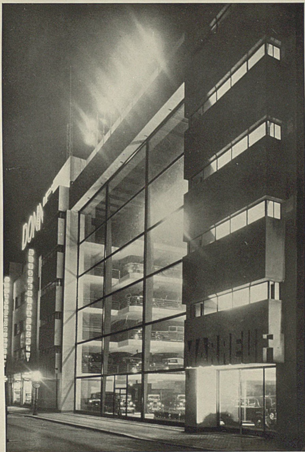
Autoausstellungshaus und Großgarage Marbeuf-Paris Architekt Laprade-Paris Lichtbilder von „Buffotot“
