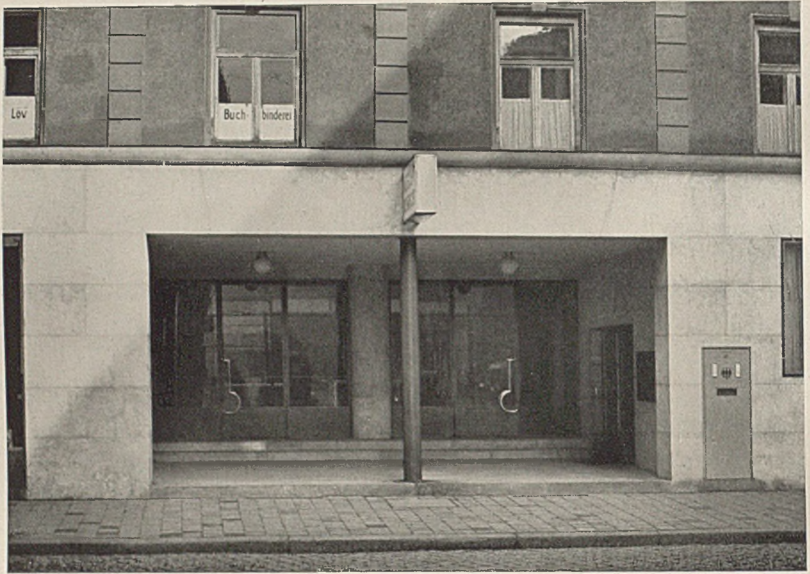
Postamt an der Theresienstraße, Einbau
