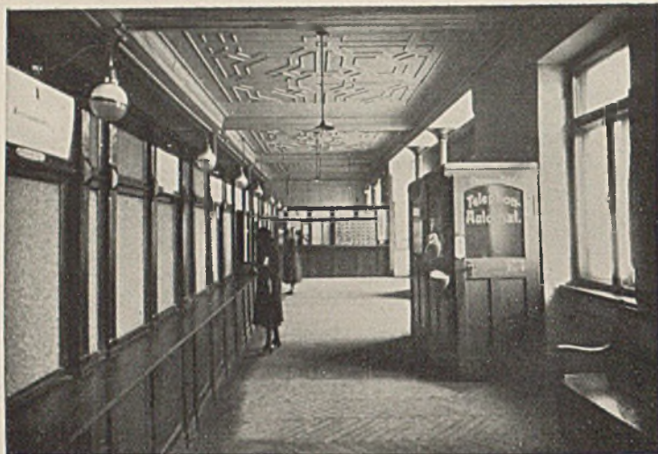
Postamt an der Leopoldstraße vor dem Umbau
