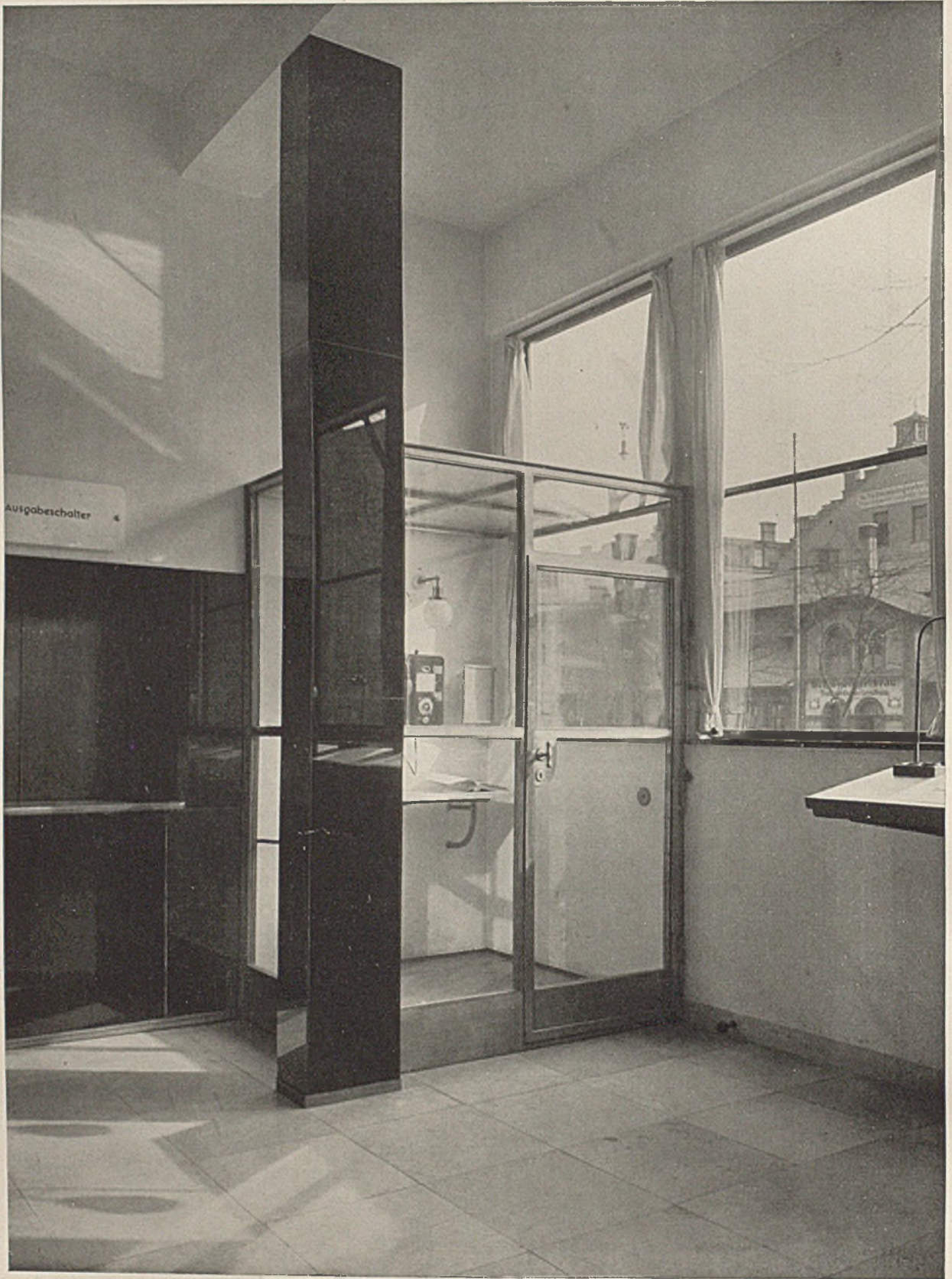
Postamt an der Leopoldstraße Schwarzverglaste Deckenstütze und Telephonzelle in der Fensterecke Detailaufnahme (hierzu Tafel 35)
