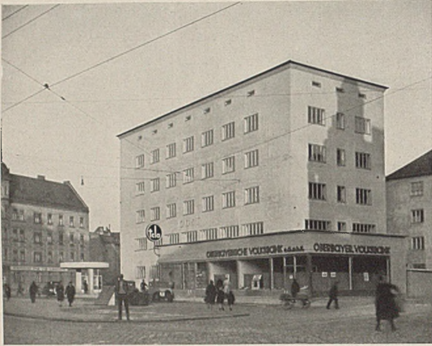
Blick aus der Deisenhofer Straße gegen das Postamt. Durch Vergleich mit dem Detail des Dachgesimses auf Tafel 31 läßt sich ein Urteil über die Wirkungsweise von Gesimsausladungen und Höhen gewinnen.
