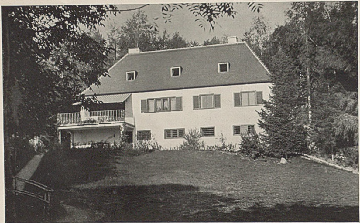
Haus Benjamin, Ebenhausen im Isartal (Baujahr 1928/29)
