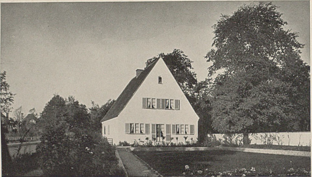
Haus Borst in Obermenzing-München (Baujahr 1928)
