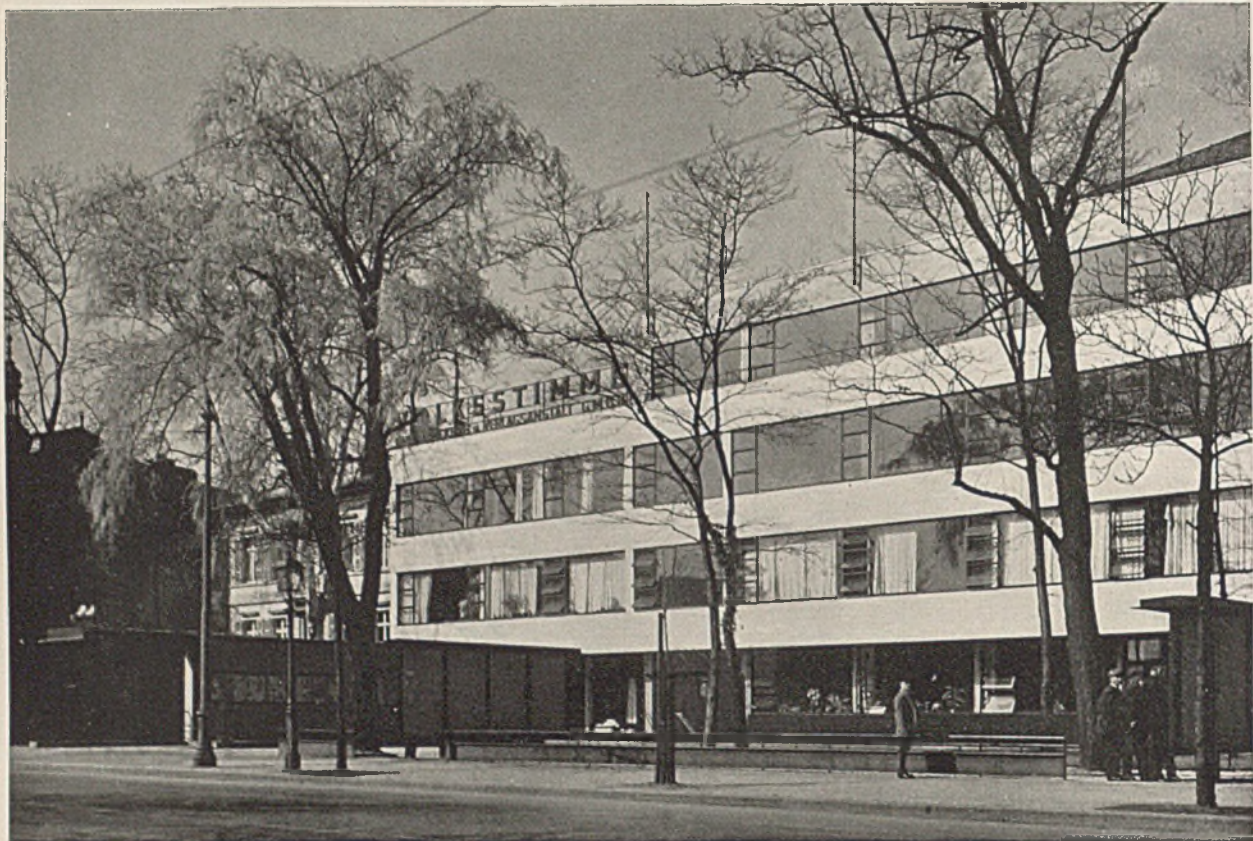
Die „Volksstimme“, Verwaltungsgebäude der Uniondruckerei in Frankfurt a. M.
