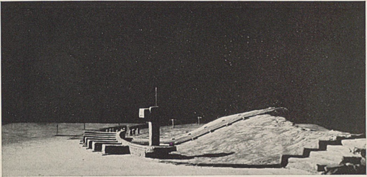
Kraftwerk mit Falleitungen, Leuchtturm, Schleusenstufen Gesamtleistung 6,48 Millionen PS, bei 32 Maschineneinheiten, je 20 000 PS, Gefälle ca. 200 m; 16 Rohrstränge, je 8,4 m Durchmesser, jeder Strang speist zwei Maschinenaggregate
