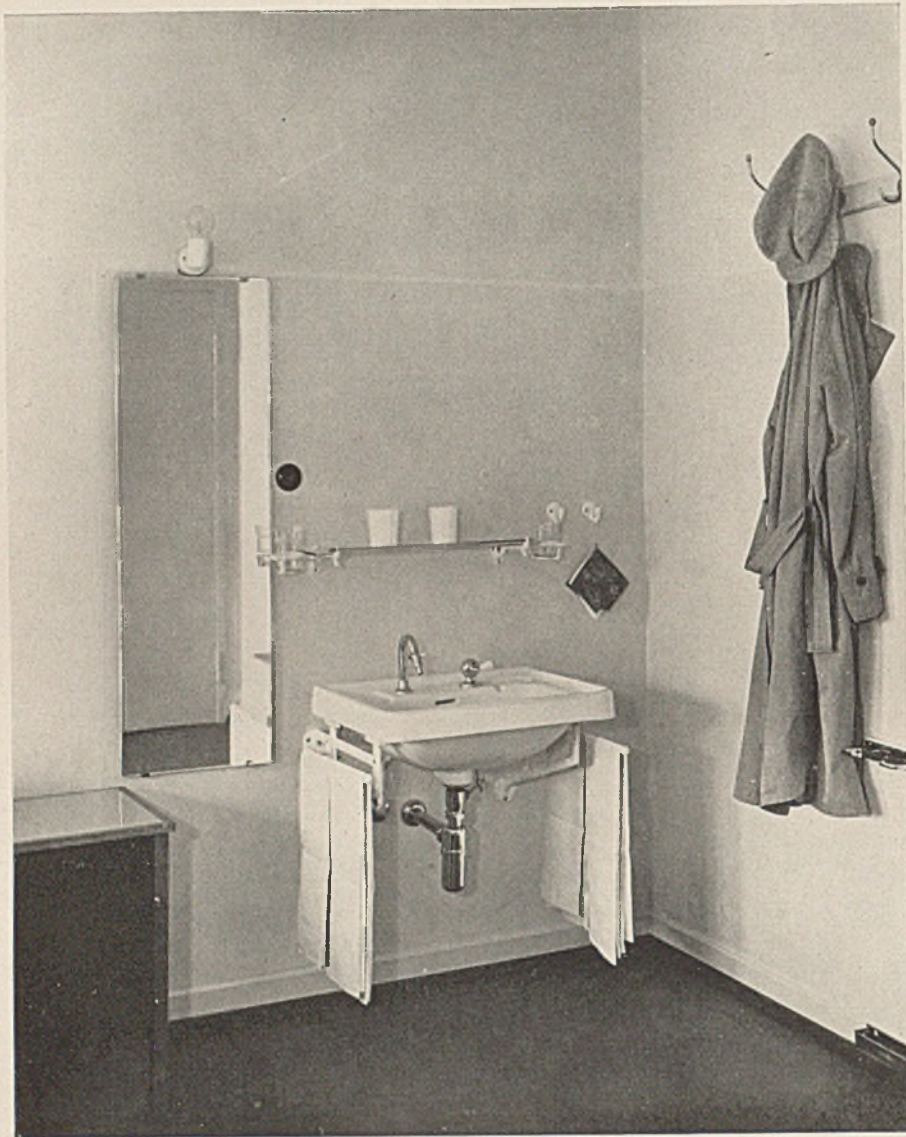
Waschecke im Ein- bettzimmer. Unten Einzelheiten von Fenster und Balkontüre
