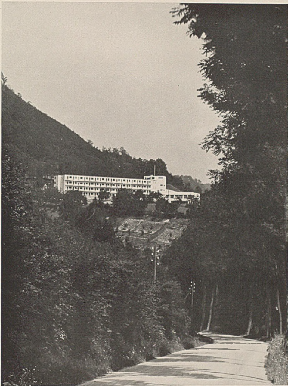
Ansicht des Ferienheimes von Süden
