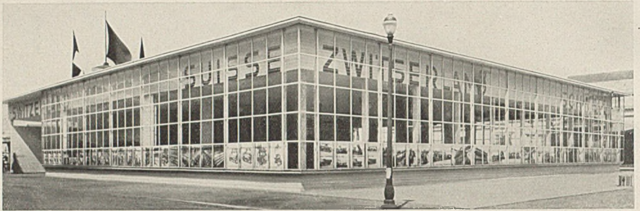
Der Schweizer Pavillon auf der Weltausstellung in Lüttich 1930. (Siehe auch Tafel 72) Architekten Kellermüller-Zürich u. Hofmann-Winterthur
