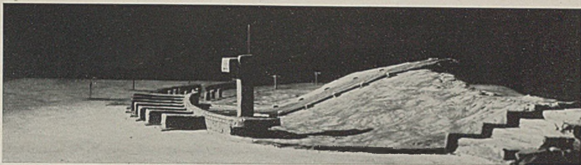
Kraftwerk mit Falleitungen, Leuchtturm, Schleusenstufen bei Gallipoli Gesamtleistung 6,48 Millionen PS. bei 32 Maschineneinheiten, je 20 000 PS, Gefälle ca. 200 m; 16 Rohrstränge, je 8,4 m Durchmesser, jeder Strang speist zwei Maschinenaggregate
