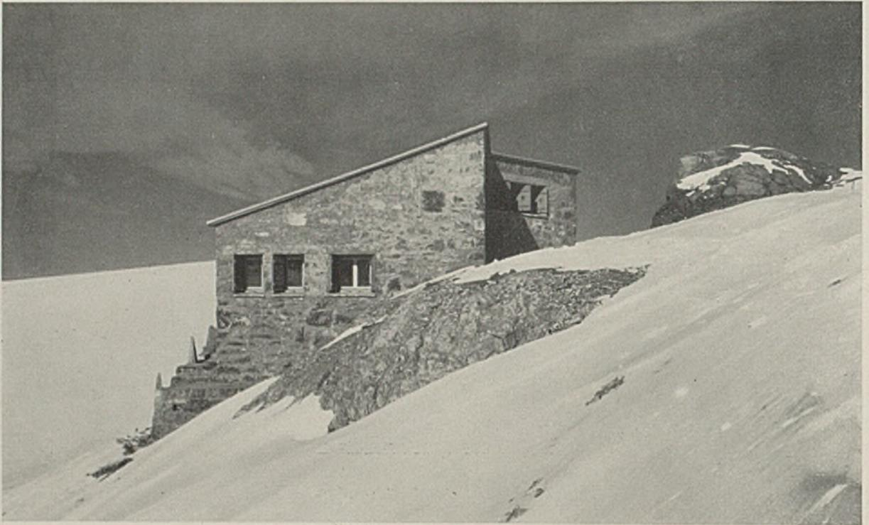
Kennzeichnend für den Grundriß ist eine den Geländekurven folgende Knickung, die es ermöglicht, den Baukörper so wenig heraustretend wie möglich zu formen und das geringste Maß von Sprengungsarbeit zu erzielen. Ein weiterer Vorteil ist die Verkürzung der Wetterseite und Ausdehnung der Aussicht- und Sonnenseite. (Rundes Eckfenster im Wohnraum!)
