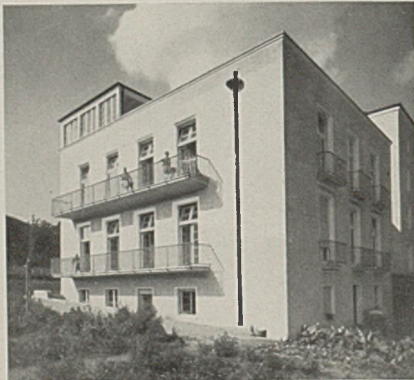
Links Westbau von Süden
