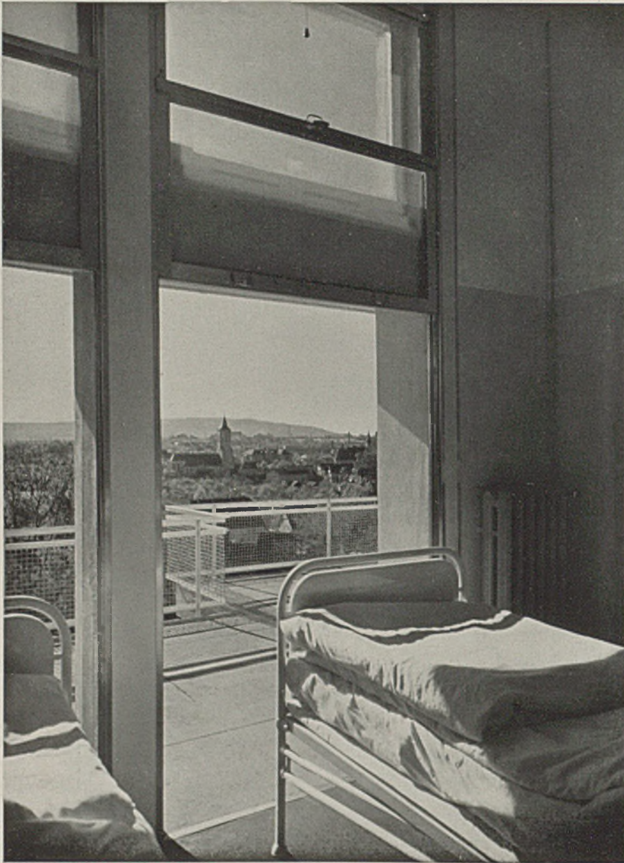
Oben ein dreiteiliges Krankensaalfenster mit Bett Durch die schräge Zwischendecke wird die Blendung vom Himmel her gemildert.
