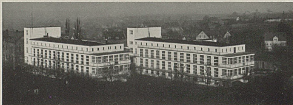
Ansicht von Südosten
